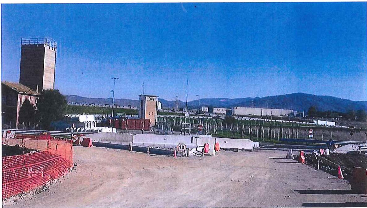
INP 202 – Innesso con viabilità direzione Civitavecchia Porto: Misto granulare non legato ed Isola centrale delimitata da cordoli in cls.
