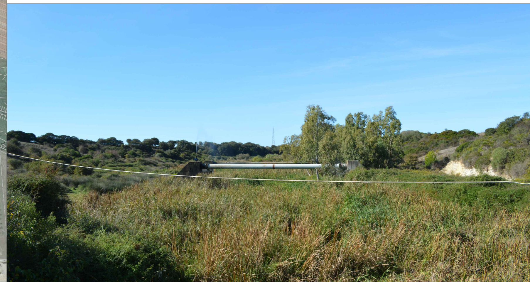
Foto 6 - Ante operam - Viadotto Sassu
