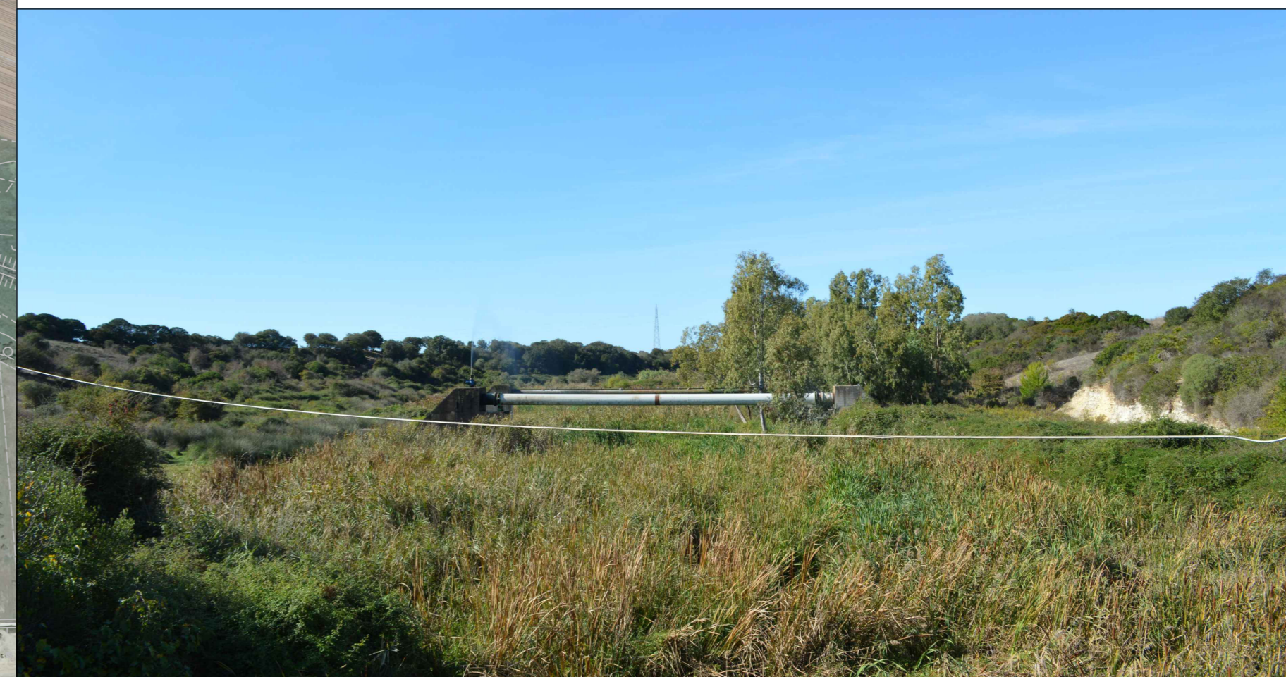
Foto 6 - Ante operam - Viadotto Sassu
