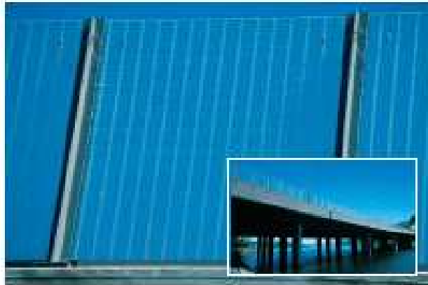
Figura 4 Esempio di trattamento di superfici trasparenti atto ad evitare le collisioni con l'avifauna (da COST 341)
