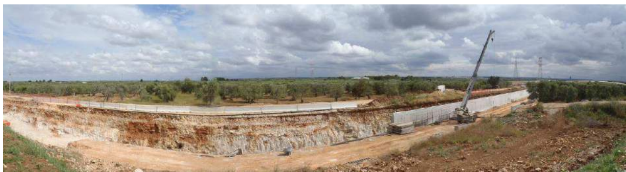
Sito VEG-7 – Panoramica 25: aspetto dell'area di cantiere. In secondo piano, arboricoltura ad olivo e mandorlo.
