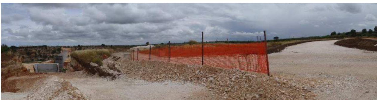
Sito VEG-6 – Panoramica 20: area di cava (a sinistra) ed incolti (a destra, sullo sfondo) in area campione.
