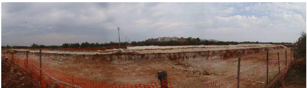
Sito VEG-5 - Panoramica 18: monitoraggio fasce campione, aspetto della fascia prossimale. Si nota lo scotico effettuato lungo l'asse del tracciato in progetto.
