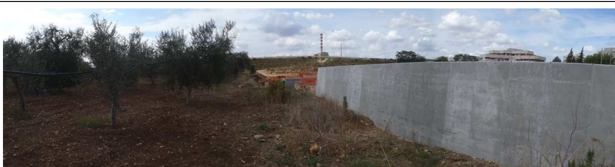
Stazione VEG-1/VEG-2 – Indagine per fasce campione: aspetto del transetto presso l'inizio della fascia prossimale. L'area di cantiere risulta ribassata rispetto al piano della campagna di diversi metri: è separata dalle parcelle agricole circostanti da un muro in cemento di nuova realizzazione.
