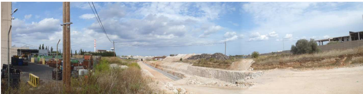
Sito VEG03: aspetto dell'area di cantiere ripresa dal transetto corrispondente alla fascia campione prossimale; sulla destra, in secondo piano, lo scheletro di un edificio in costruzione abbandonato; sulla sinistra è presente un deposito di materiale industriale.
