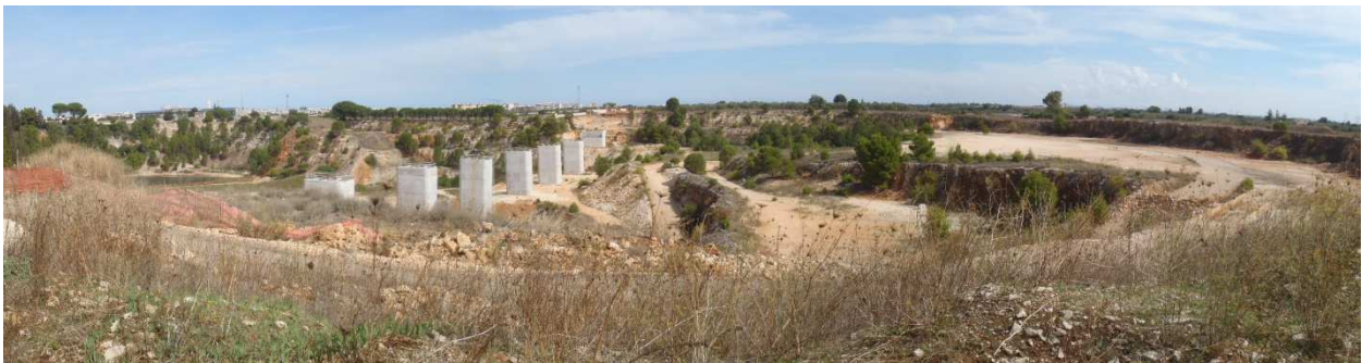
Sito VEG-6 –Aspetto dell'area di rilievo in corrispondenza della cava di inerti, al centro della quale sono visibili le pile del viadotto di nuova realizzazione.
