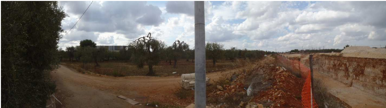
Sito VEG-5 – Aspetto dell'area di rilievo: sulla sinistra è visibile la trincea di nuova realizzazione; sulla destra le parcelle olivetate ed un annesso industriale (capannone, sullo sfondo) con relativa strada bianca d'accesso.
