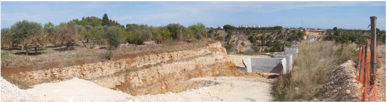
Stazione VEG-6 – Consumo di fitocenosi: la trincea di nuova costruzione fiancheggiata da incolti (a destra) e oliveti (a sinistra); sullo sfondo l'area di cava.
