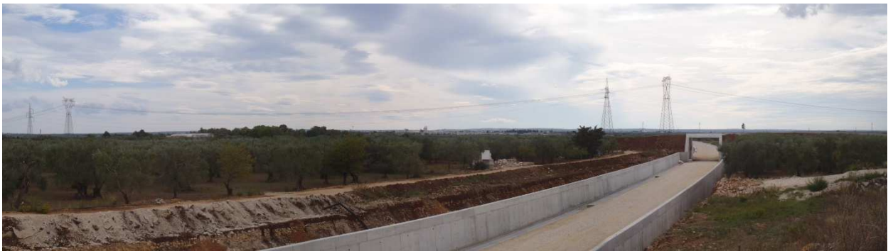
Sito VEG-7 –Aspetto dell'area di rilievo: in primo piano la trincea di nuova realizzazione.
