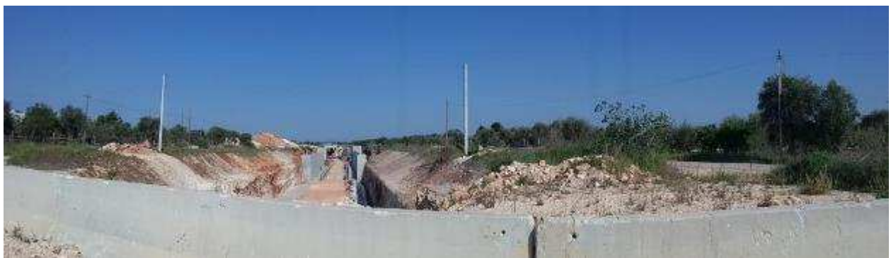
Sito VEG-5 – Aspetto dell'area di rilievo: in primo piano è visibile la trincea di nuova realizzazione.
