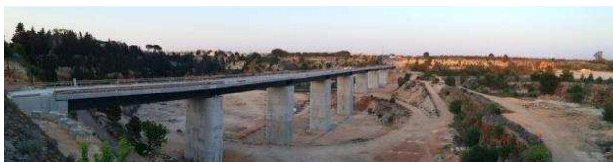
Stazione VEG-6 – Consumo di fitocenosi: il viadotto di nuova costruzione e l'area di cava.
