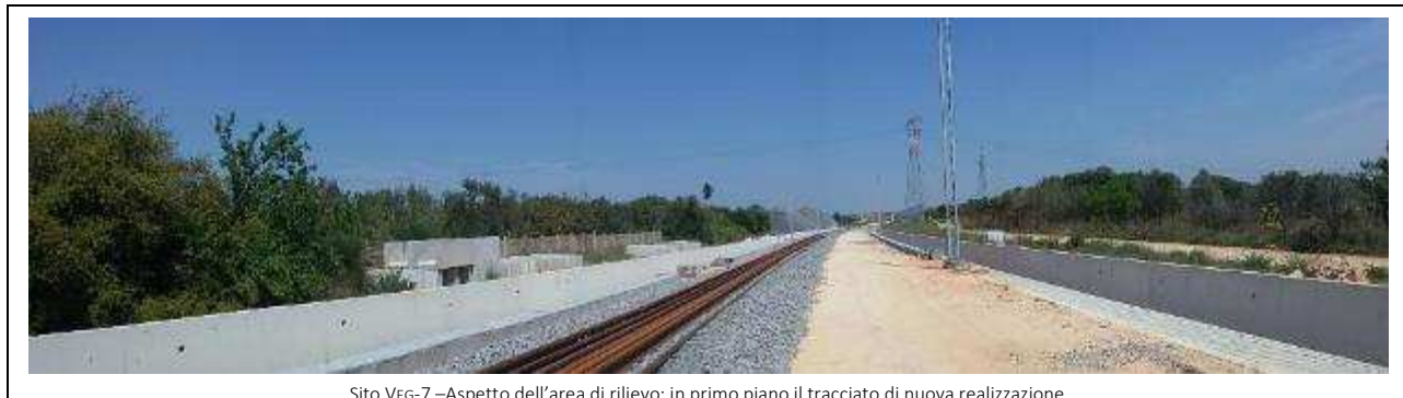
Sito VEG-7 –Aspetto dell'area di rilievo: in primo piano il tracciato di nuova realizzazione.
