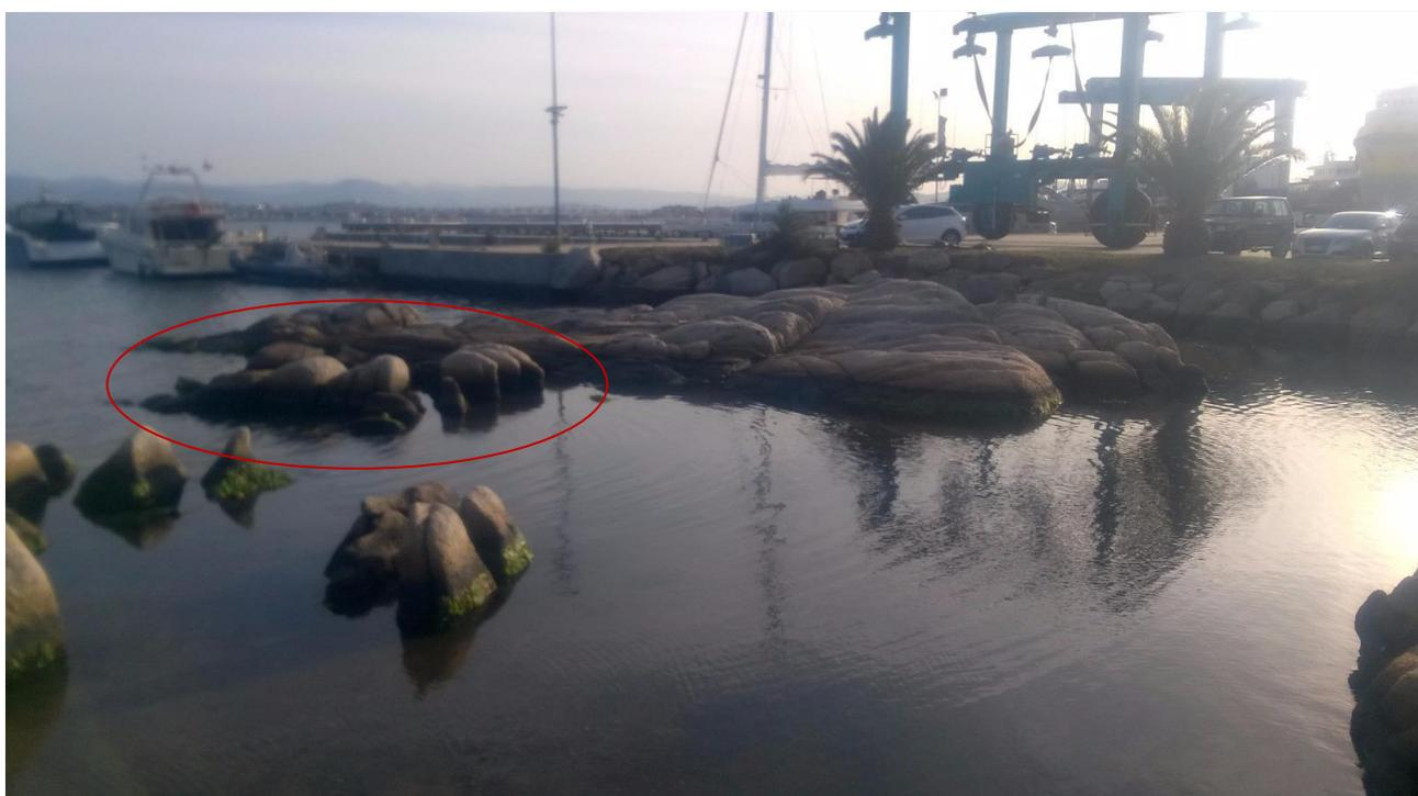
I massi verranno imbragati con apposite fasce e movimentati tramite l'utilizzo di un'autogru avente idonea capacità di carico.
