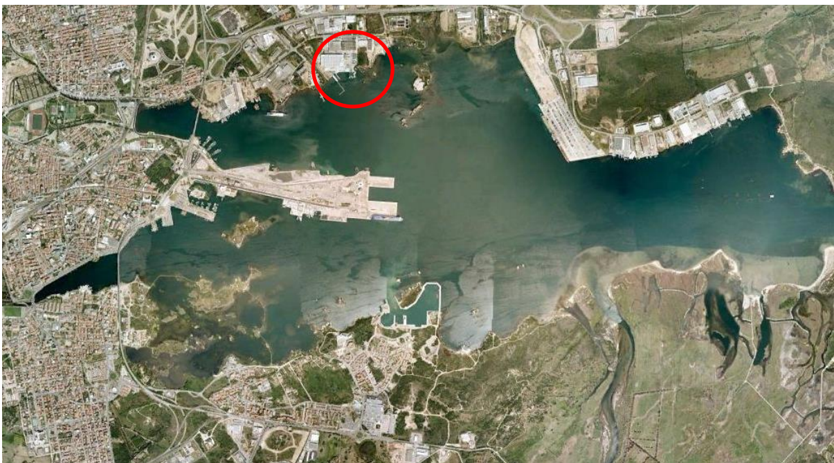
Figura 1: Vista aerea della zona interessata dal progetto.
