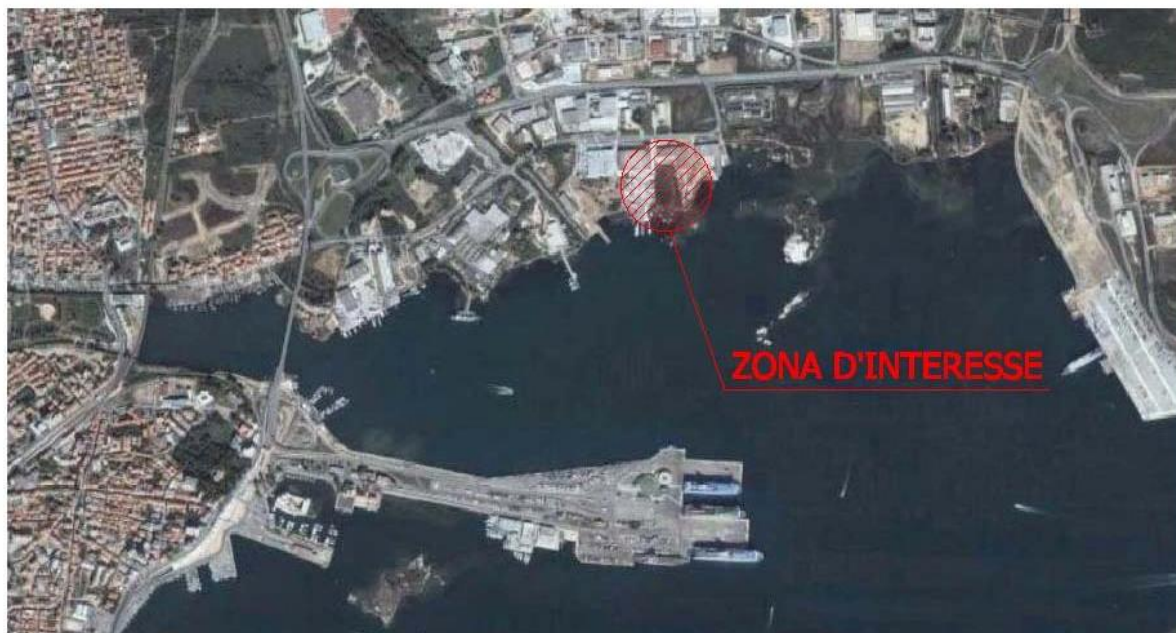
Figura 2: Vista aerea della zona interessata dal progetto
