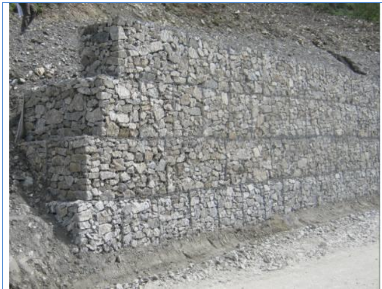
Esempio di opera in gabbioni - Fonte HE
