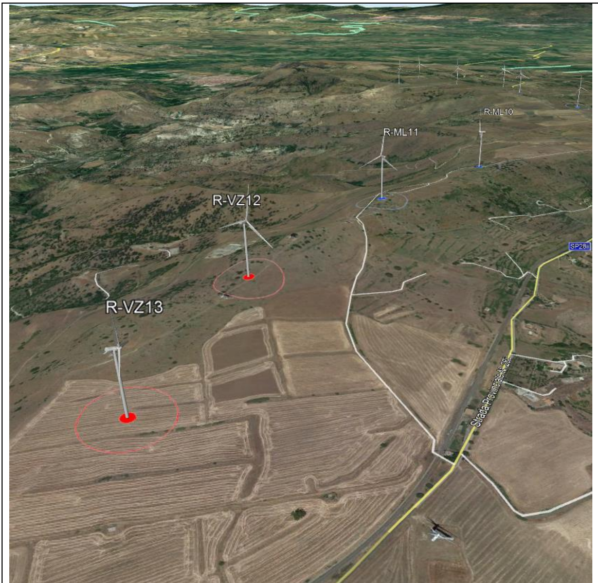
Vista degli aerogeneratori RML10, RML11, R-VZ12, R-VZ13 (sullo sfondo si osservano i precedenti)
