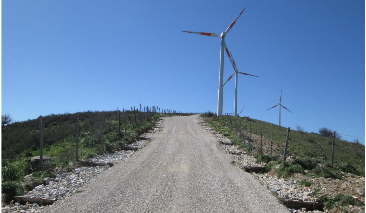
Figura 3.1: Sistema di fossi di guardia con fondo rivestito in pietrame e briglie.
