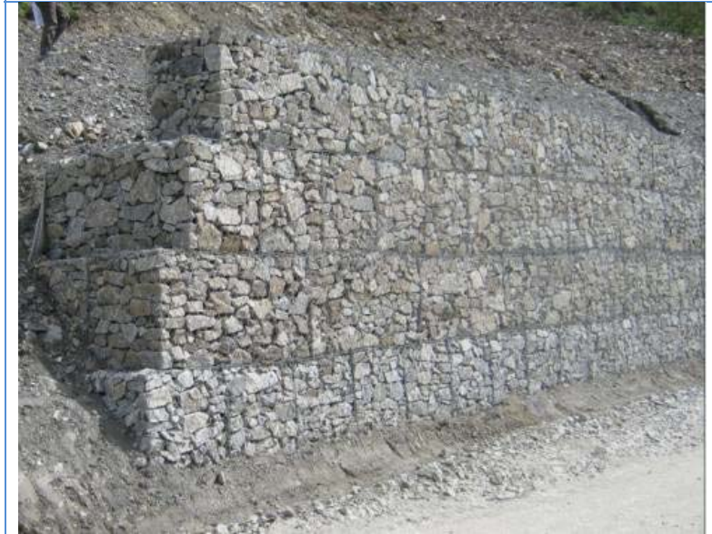
Esempio di opera in gabbioni - Fonte HE
