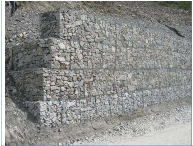
Esempio di opera in gabbioni - Fonte HE
