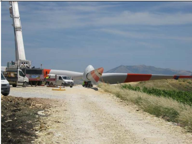
Particolare del supporto in acciaio su cui è collocato il rotore
