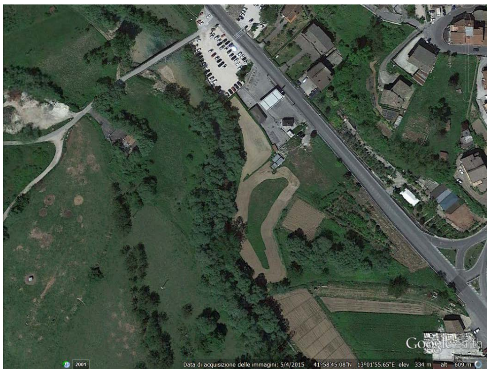
Figura 6-10: Veduta generale dell'area di collocazione dello Sbarramento e della Centrale (fonte Google Earth)
