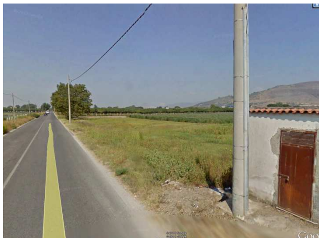
Fig. 4. SP 74 “Ponte dei Cani” in corrispondenza del nuovo accesso
