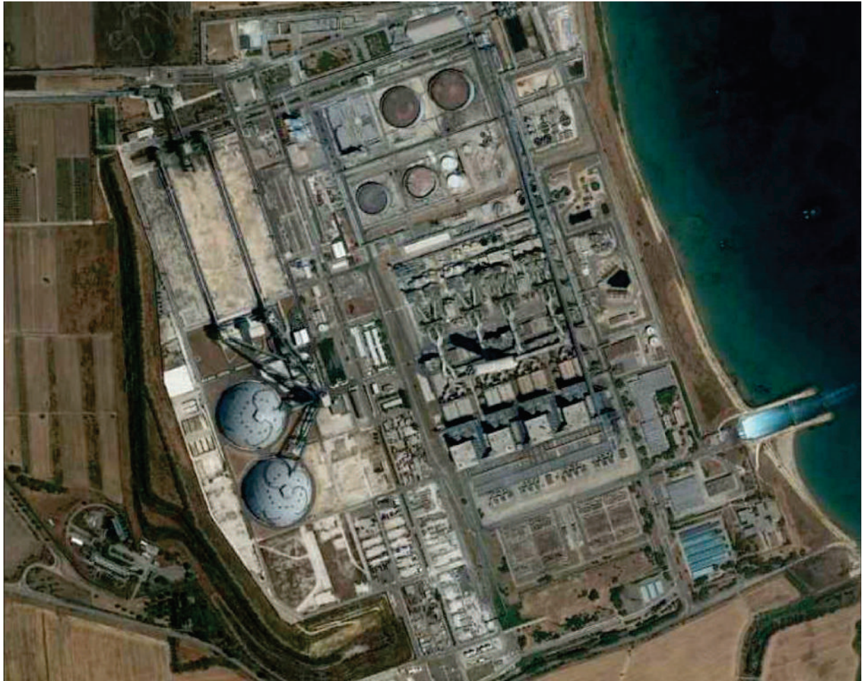
Figura 5.6.3 – Brindisi Sud – Ante operam
