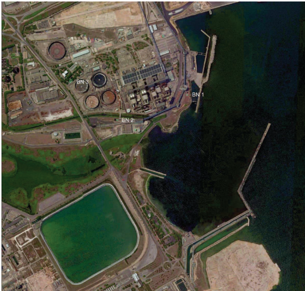
Figura 5.6.2 – Brindisi Nord – Post operam, viene indicata la localizzazione delle vasche interrante
