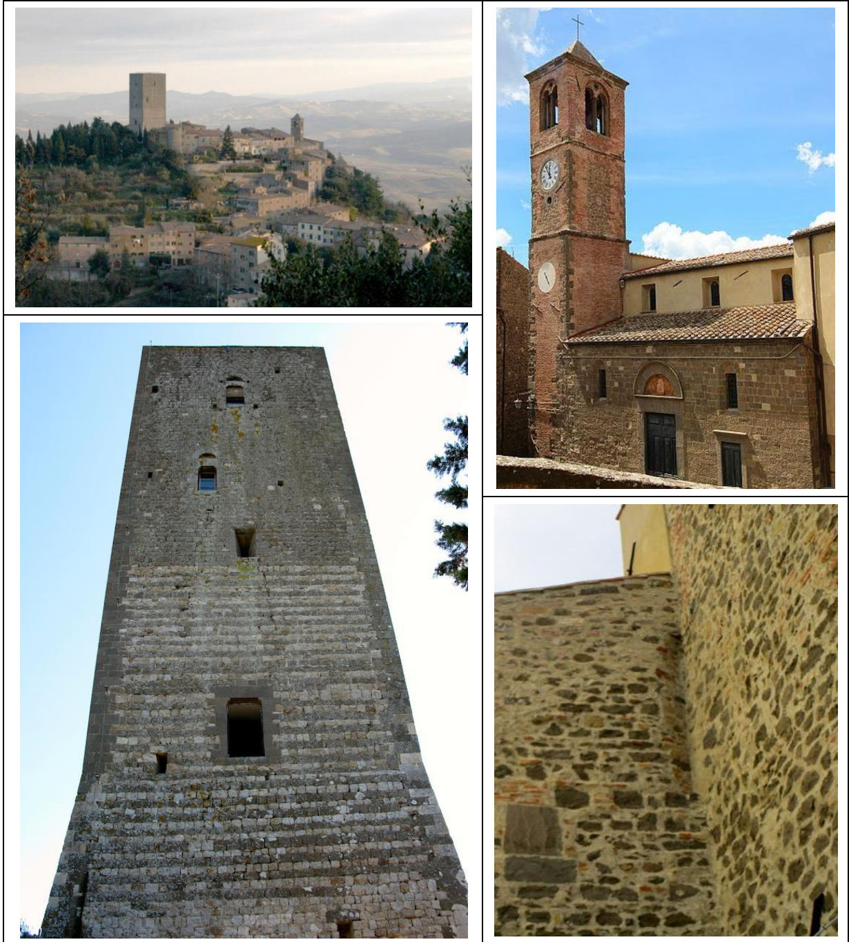
Figura 1. Esempi di edifici storici in Selagite nel nucleo di Montecatini Val di Cecina (a sinistra: Torre Belforti, in evidenza nella panoramica del paese (sopra) e vista dal basso (sotto); a destra: Chiesa di San Biagio (sopra) e particolare di un edificio del centro storico (sotto))
