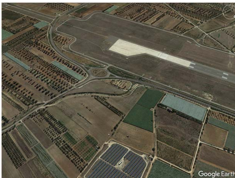
Figura 12 - Attraversamento del sedime aeroportuale da parte del Fosso delle Monache.
