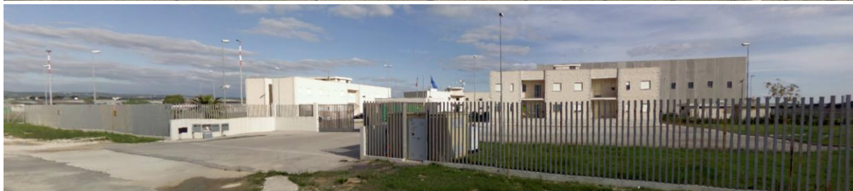
Figura 132 – Viste strutture aeroportuali esistenti
