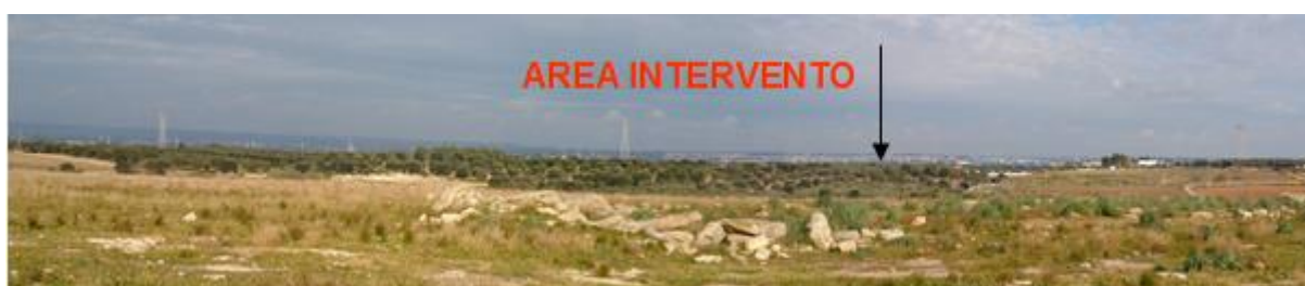
Figura 101 - Punto di vista fotografico "10" dalla Masseria Palombara (10).
