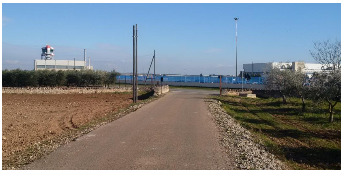
Figura 69 – Punto di vista fotografico “34” – vista dalla strada di accesso Masseria Rosario (t22).
