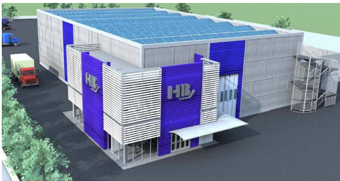
Figura 129 – Vista SUD-OVEST Hangar HB (Edificio 11)
