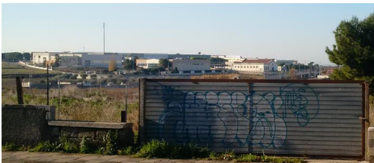
Figura 15 - Zona industriale-commerciale di Grottaglie da via Leone XIII (F9).
