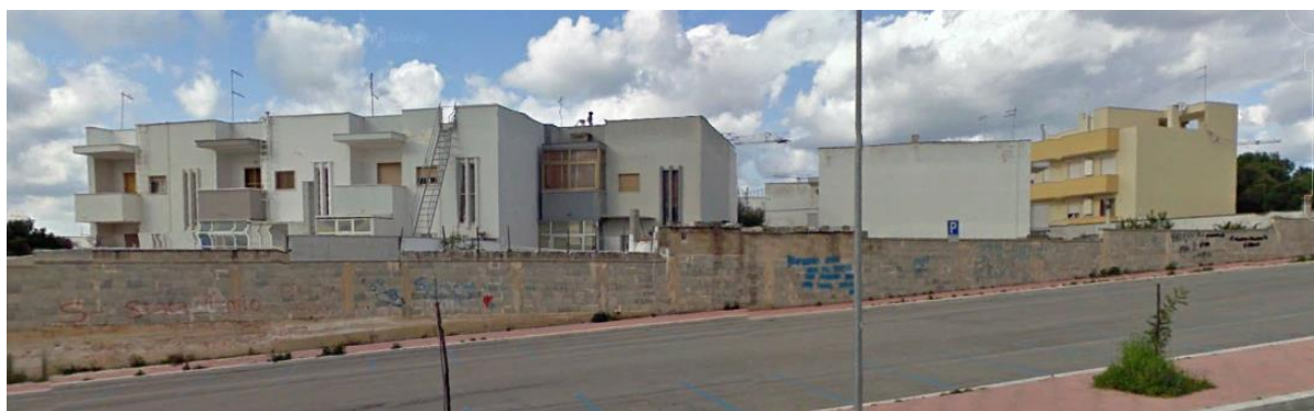
Figura 14 - Fronte edificato via dello Sport (F6).
