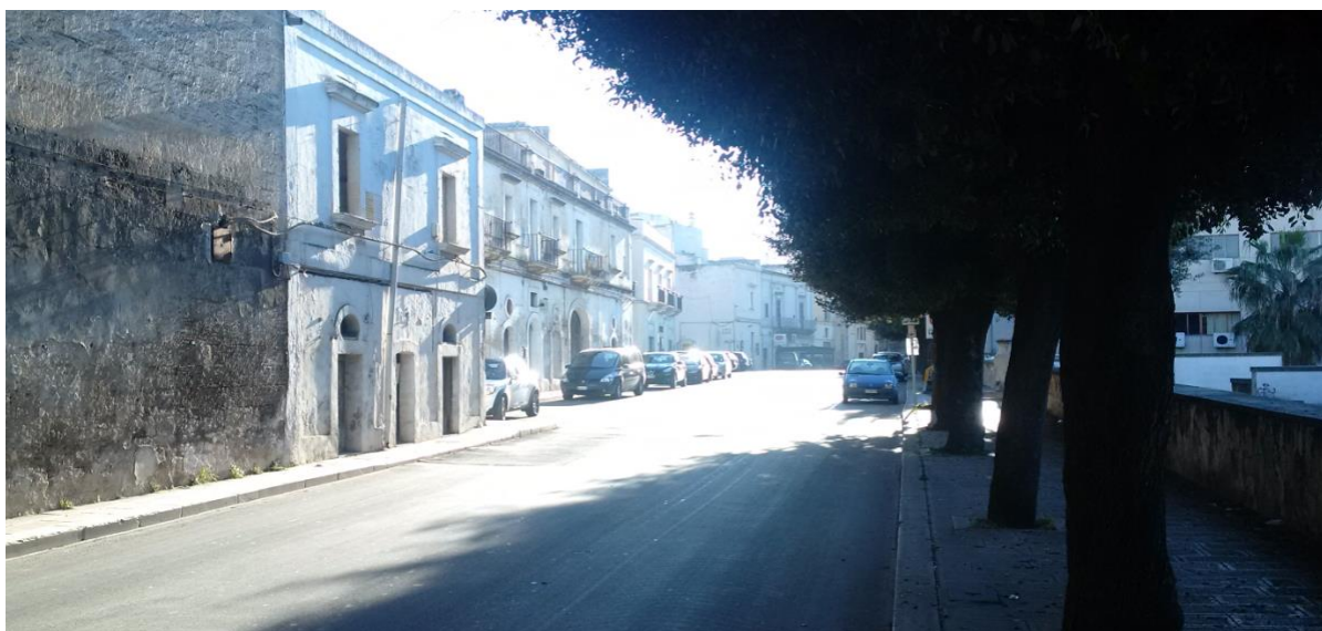
Figura 10 – Fronte edificato via Martiri D'Ungheria (F1).
