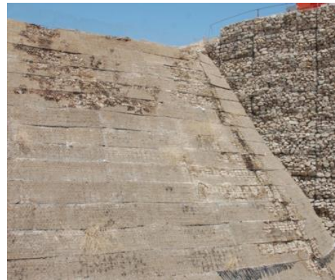
Mancanza di crescita di vegetazione sul paramento
