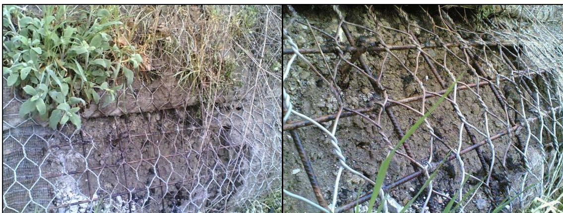
**Figura 8. Perdita di materiale fine a causa di incendio e conseguente danneggiamento del ritentore di fine. Il terreno vegetale dietro al paramento rimane esposto.**
