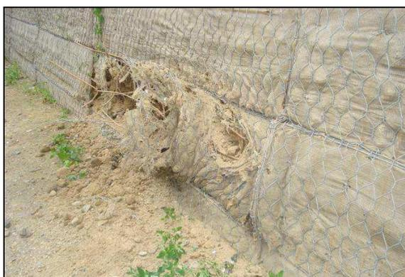
**Figura 7. Svuotamento del riempimento vegetale dovuto ad un urto sul paramento**
