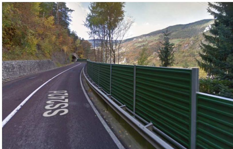
Figura 23 – Barriera antirumore esistente nel tratto con altezza 2,5 m e 2,0 m
