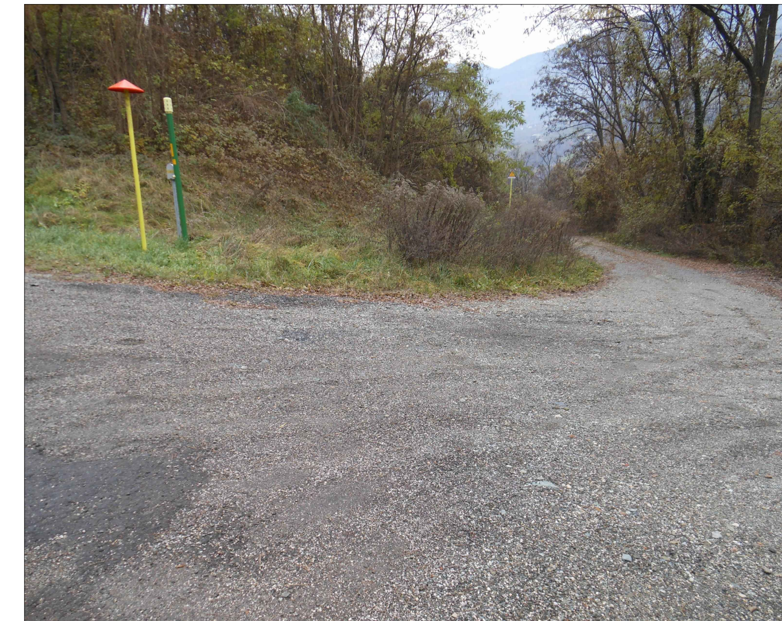
FOTO 5 - VISTA DEVIAZIONE STRADA STATALE 242D
