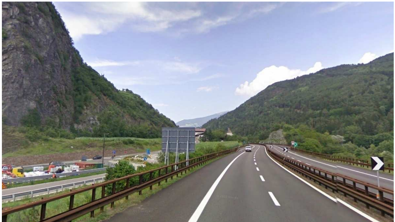
Area in cui è prevista l'attraversamento dell'Isarco, tramite Viadotto. Sulla sinistra si intravede lo: svincolo tra la provinciale e la SS12 da ricollocare.
