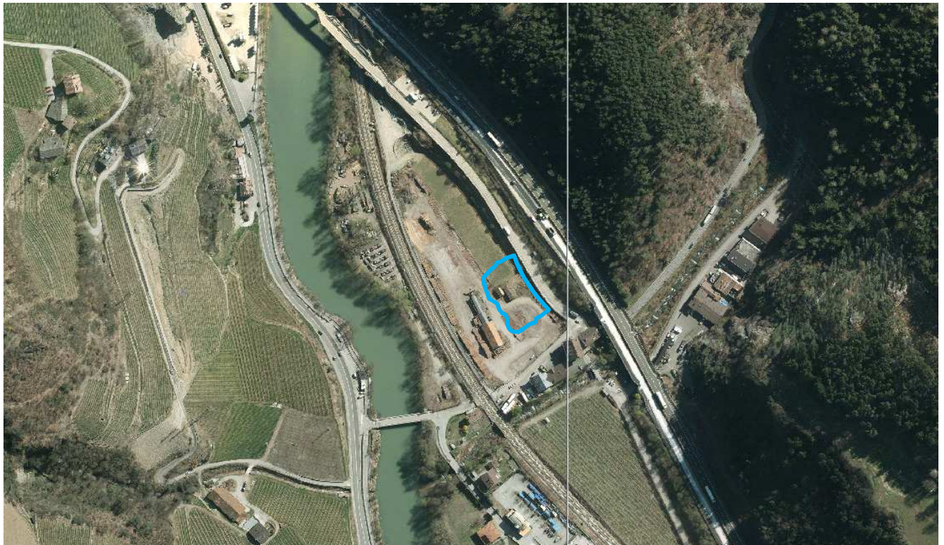
Vista aerea A.S.03B
