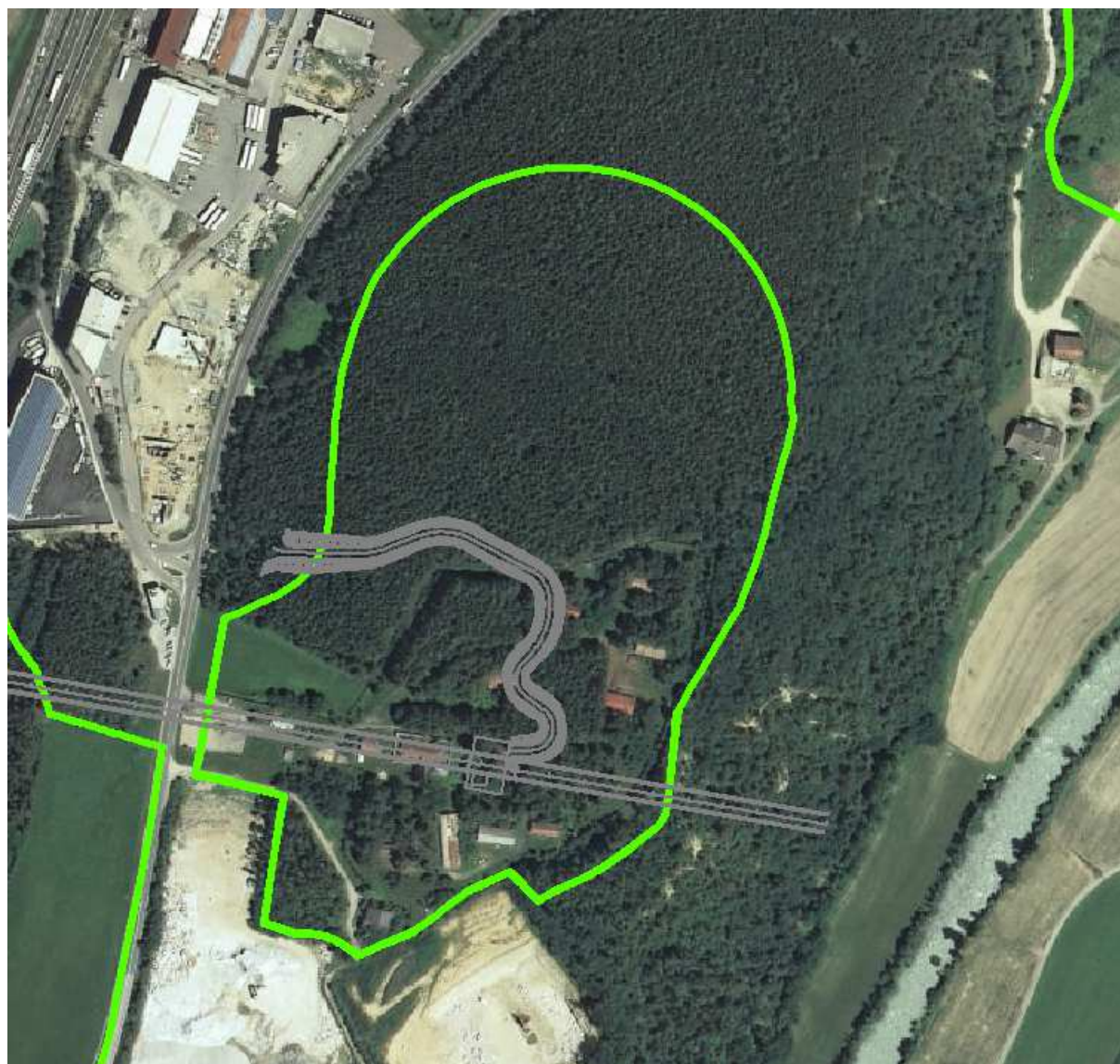
Figura 3-13 – Foto aerea con la perimetrazione del deposito “A- Forch” (verde) e relativa viabilità (grigio).
