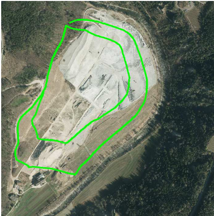
Figura 3-20 – Fotoaerea con la perimetrazione del deposito E – Deposito polmone.
