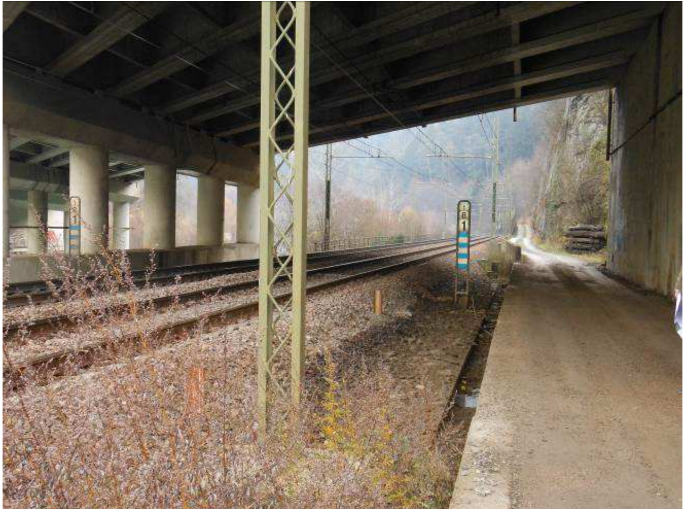
Strada di servizio delle ferrovie in affiancamento della linea ferroviaria. Punto in corrispondenza del cavalcavia autostradale A22.
