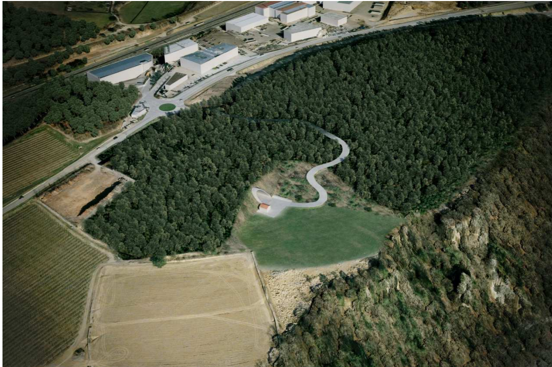
Figura 6-9 - Deposito Forch su foto aerea, situazione post operam.
