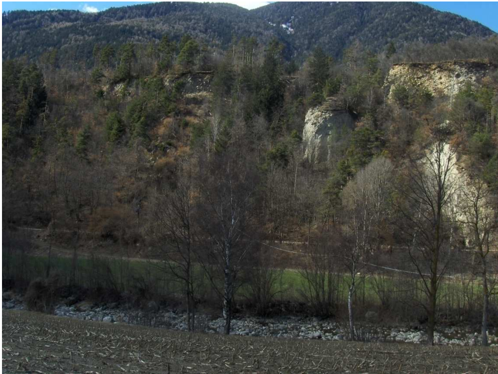
Scarpata del deposito Forch.
