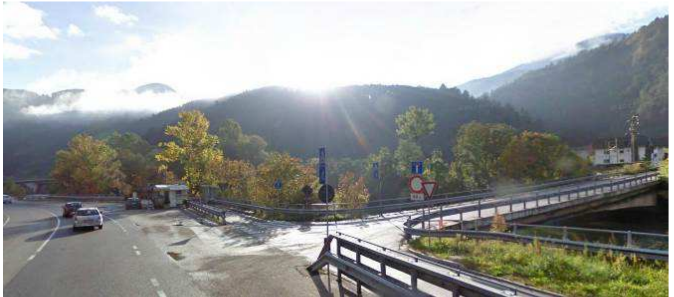
Svincolo sul ponticello esistente su strada S.S.12
