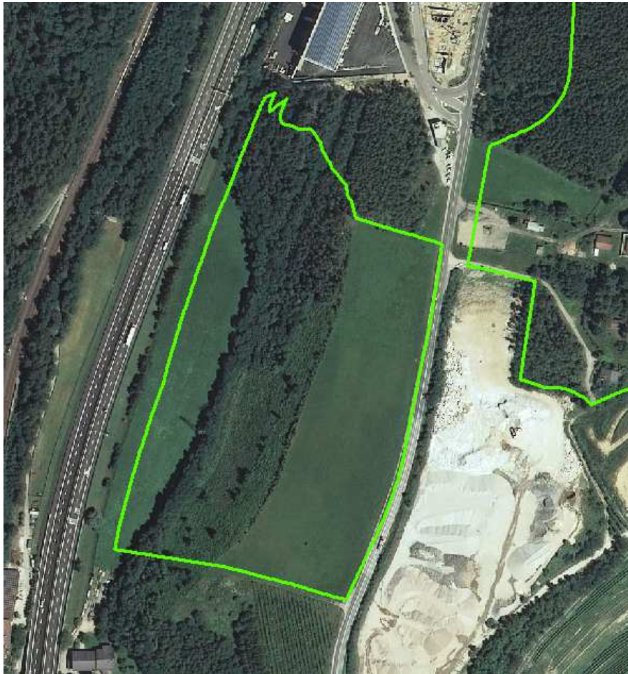
Figura 3-15 – Fotoaerea con la perimetrazione del deposito di Unterseeber..
