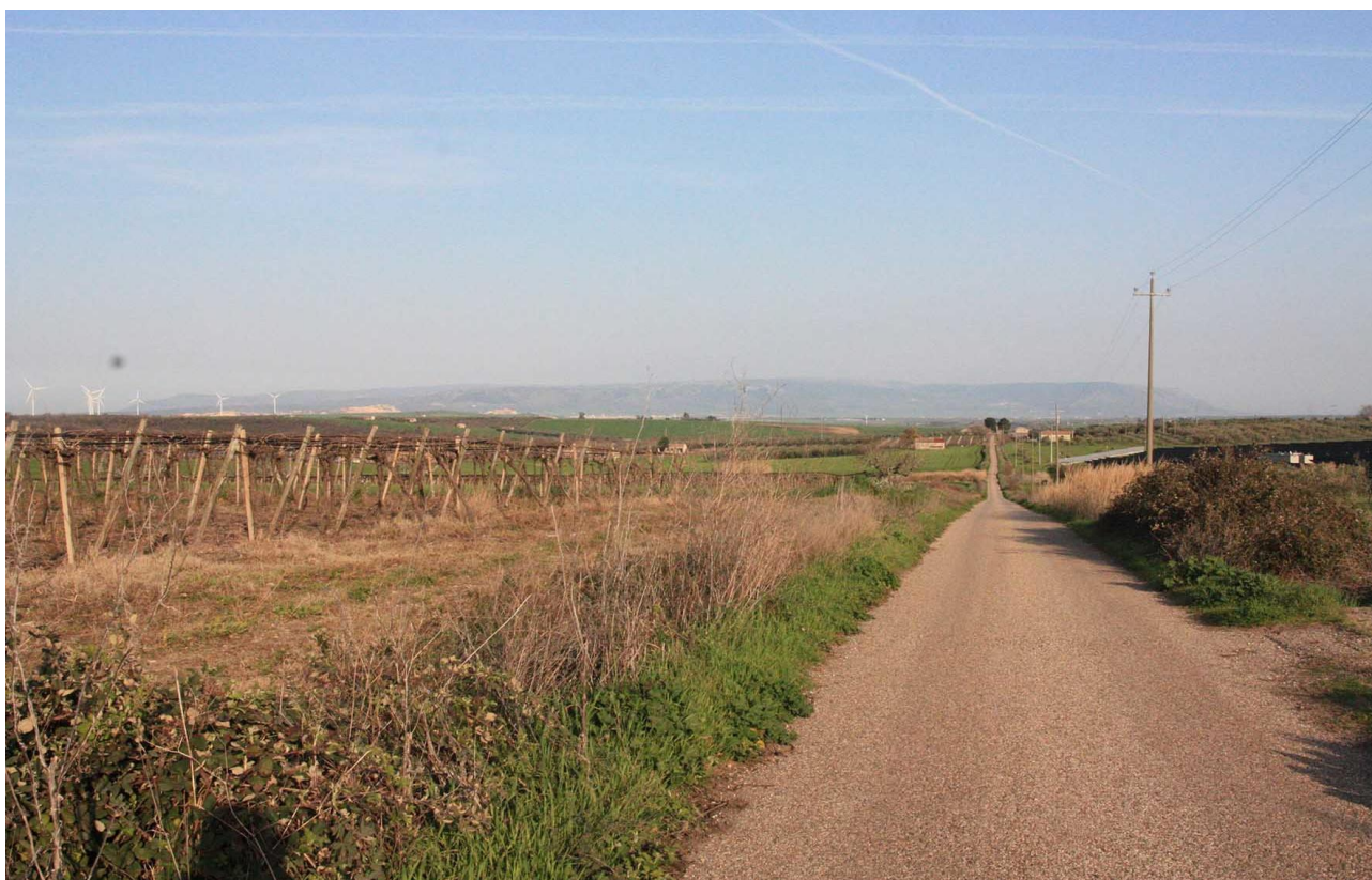
Foto 4. Strada interpodereale che si diparte dalla Strada Provinciale 31 San Paolo di C. – Ripalta , prevista per servire il parco eolico di progetto, per condurre all' aerogeneratore A3. La strada è larga solo 3 mt e non è idonea, anche per caratteristiche strutturali, al passaggio di mezzi per trasporto eccezionale fino a 100 tonnellate.
