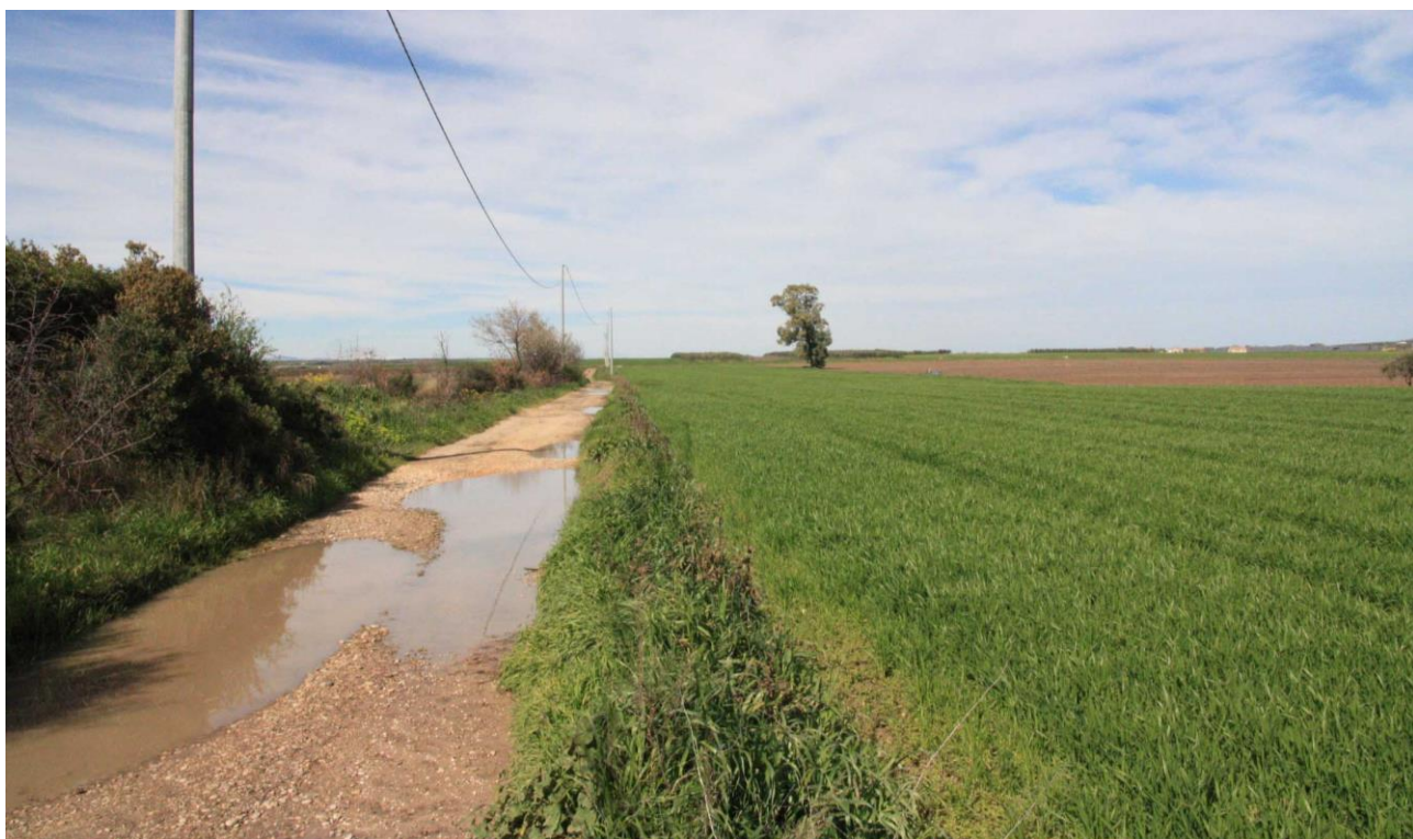
Foto 13. Altro tratto sterrato di strada, nei pressi del Vallone Chiagnemamma vicino alla zona in cui dovrebbe essere ubicato l'Aerogeneratore A9. La strada è del tutto inadeguata al transito di mezzi di trasporto eccezionale.
