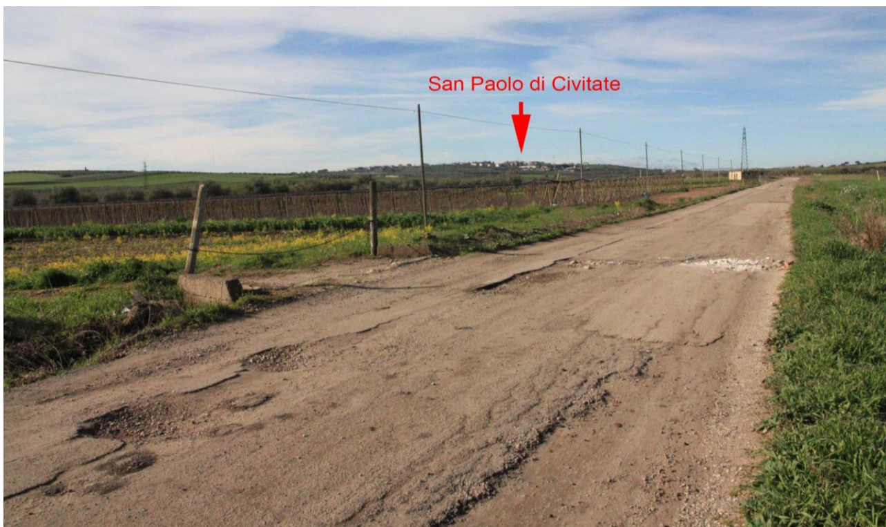
Foto 6. Strada Vicinale Titolone nella zona dalla quale dovrebbe partire la pista di nuova realizzazione che, secondo il progetto dovrebbe condurre all'Aerogeneratore A4. Questa strada esistente, nello stato in cui è attualmente non è idonea al passaggio di Trasporto Eccezionale fino a 100 tonnellate.
