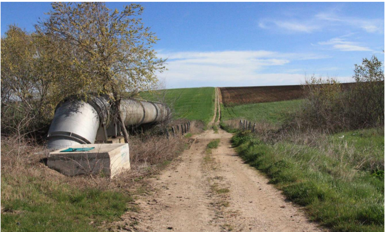
Foto 11. Tratto sterrato della Strada Vicinale Titolone , in corrispondenza del ponte sul Vallone Chiagnemamma , zona tra le aree in cui è prevista l'ubicazione degli Aerogeneratori A7 e A8. Anche qui l'immagine illustra chiaramente la inadeguatezza della strada (larga 2,8 metri) al transito di mezzi eccezionali del peso fino a 100 t..
