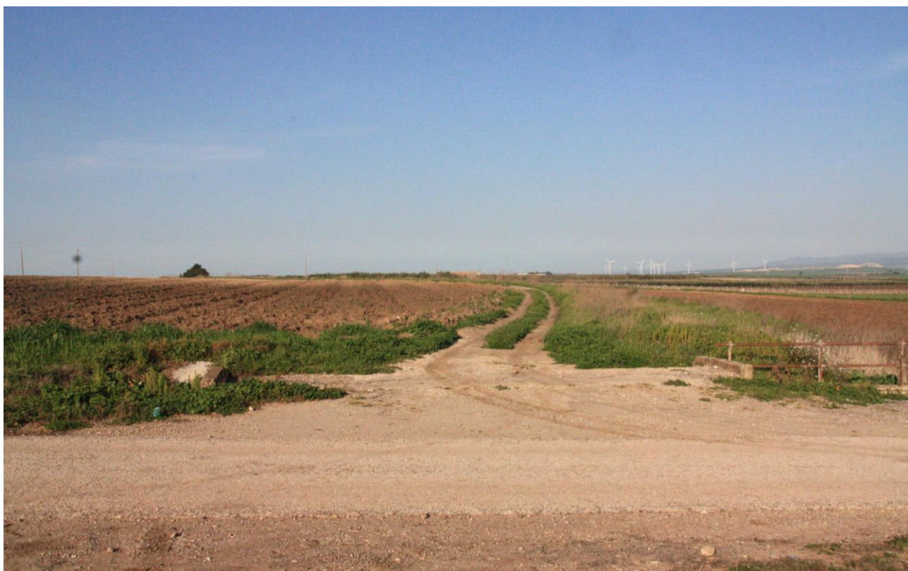
Foto 2. Punto di accesso, dalla suddetta strada interpodereale (trasversale), alla strada sterrata (in fondo) che dovrebbe condurre al tratto di strada di nuova costruzione (come da progetto) a servizio dell'aerogeneratore A2. La strada, sterrata, larga solo 2,80 mt e non è evidentemente idonea per sostenere il passaggio di mezzi per trasporto eccezionale
