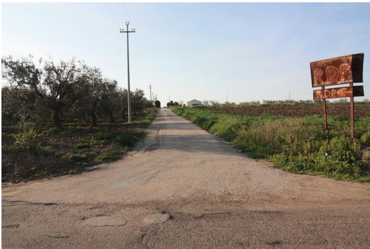
Foto 1. Punto di accesso, dalla S.P. 31, alla strada interpodereale (in evidenza) dovrebbe condurre alle piste di nuova costruzione a servizio degli aerogeneratori A1 e A2. La strada interpodereale è larga solo 3,80 mt.
