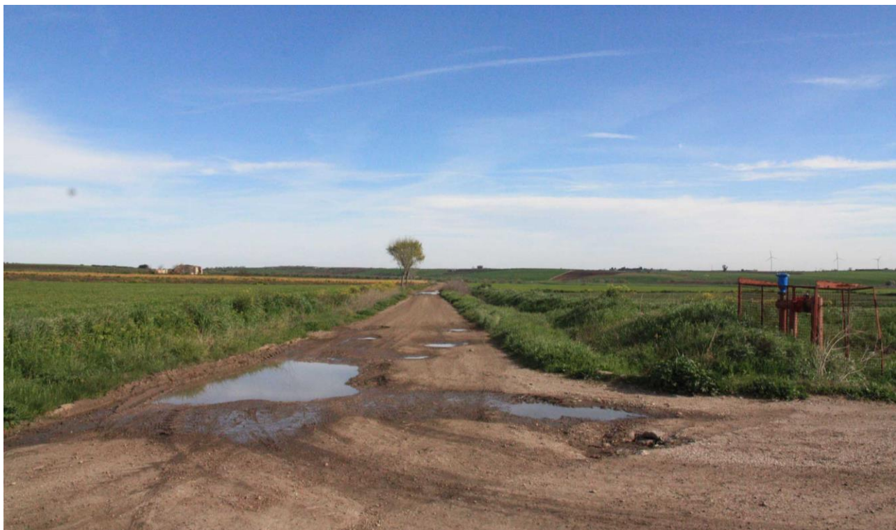
Foto 8. Strada Vicinale Titolone all'intersezione con la Strada Vicinale Serracapriola-Apricena nella zona dalla quale dovrebbe partire il nuova pista di progetto che dovrebbe condurre all'Aerogeneratore A6. Ancora una volta è evidente lo stato di dissesto in cui versa la strada. E' visibile inoltre sulla destra una condotta del Consorzio di Bonifica della Capitanata che percorre la strada lungo il lato destro in forma interrata. Il manto stradale in asfalto è quasi scomparso.
