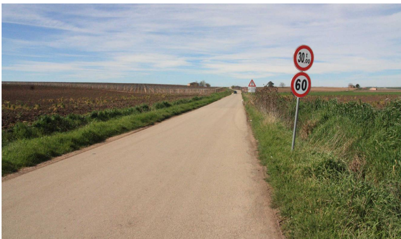
Foto 15. Tratto iniziale della Strada Provinciale 36 , indicata nella TAV. 2 del progetto come strada di accesso alla rete viabilità esistente interpoderali comunale da impiegare a servizio dell'impianto eolico. Anche questa strada, la più grande delle strade esistenti e quella in migliori condizioni non risulta idonea al transito di mezzi di Trasporto Eccezionale della portata di quelli previsti per la realizzazione dell'impianto eolico di progetto, come si evince dalla segnaletica.
