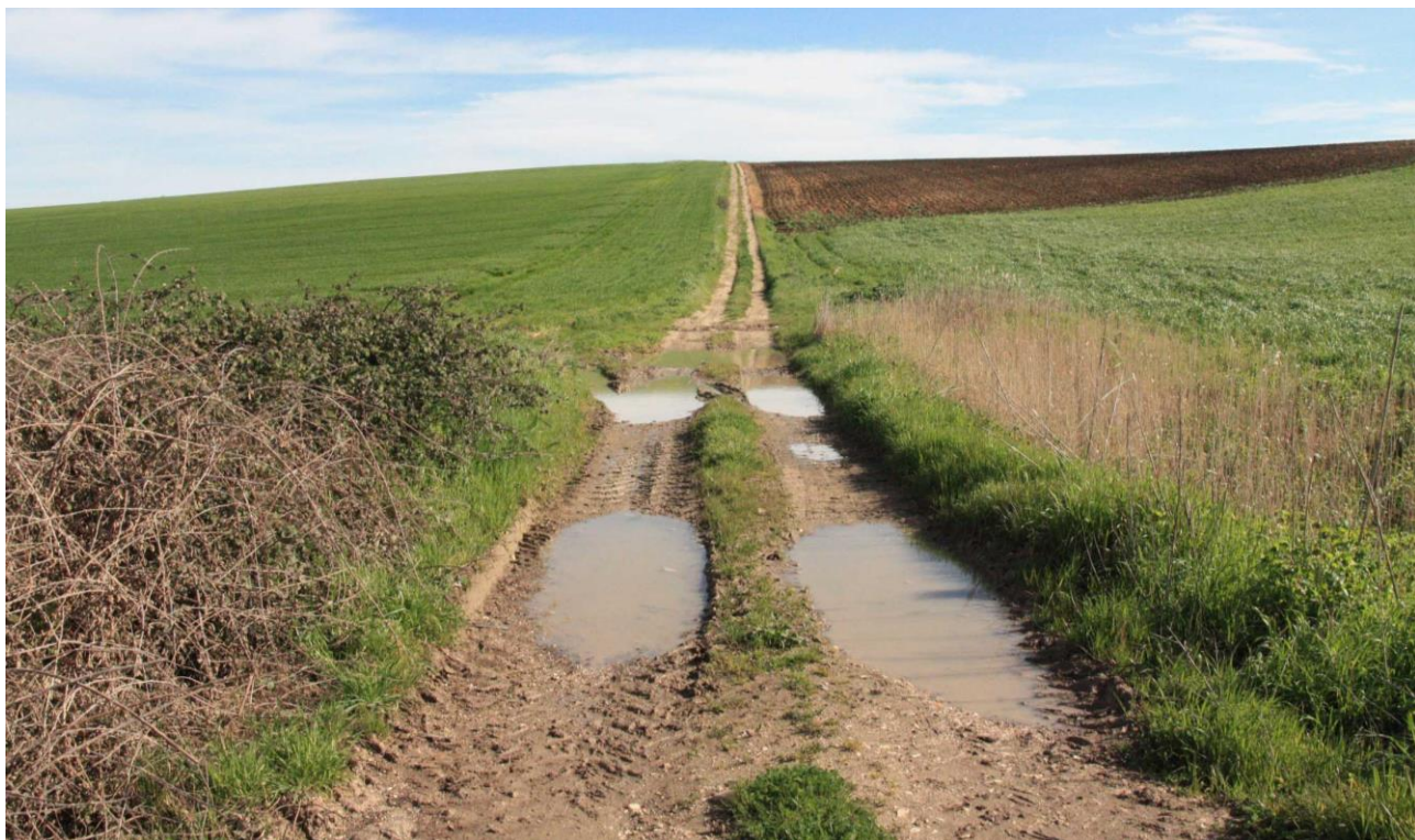
Foto 12. Tratto sterrato della Strada Vicinale Titolone , oltre il ponte sul Vallone Chiagnemamma , nella zona in cui è prevista l'ubicazione dell'aerogeneratore A8. L'immagine evidenzia ancora una volta come una strada esistente di questo tipo e in questo stato richiederebbe non dei semplici interventi puntuali di sistemazione, prima di essere utilizzata come viabilità da impiegare per il parco eolico, ma un rifacimento integrale.
