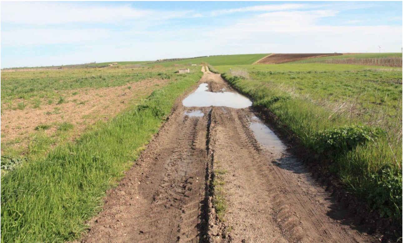
Foto 10. Strada Vicinale Titolone nella zona dalla quale dovrebbe partire il nuovo tratto di strada di progetto che dovrebbe condurre all'Aerogeneratore A7. La strada, ampiamente dissestata, larga solo 2,8 mt, è priva di fondo e manto idonei al trasporto eccezionale necessario per la realizzazione dell'Impianto Eolico.
