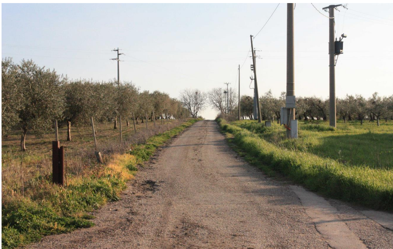
Foto 5. Strada interpodereale che dovrebbe condurre al tratto di strada di nuova realizzazione (da progetto) per l'accesso al previsto aerogeneratore A3. Anche in questo caso si tratta di una strada della larghezza di soli 3 mt non idonea al transito di trasporto eccezionale fino a 100 tonnellate
