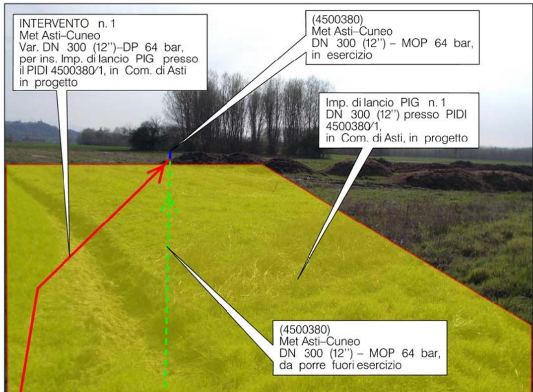
**Intervento n. 1, Met. Asti Cuneo DN 300 (12"), Variante DN 300 (12") DP 64 bar per inserimento Impianto di Lancio PIG DN 300 (12") presso il PIDI 4500380/1 in Comune di Asti (AT)**
