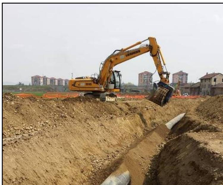
**Fig. 8/D: Rinterro della condotta**
