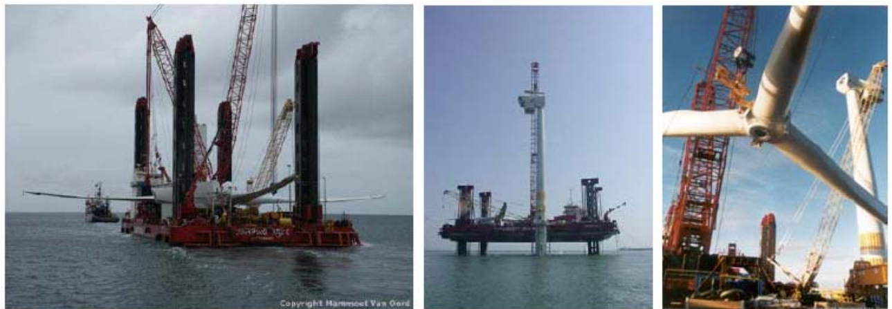
Figura 3.23: Installazione della turbina da 3,6 MW, con il metodo tradizionale, nel progetto di Arklow.
