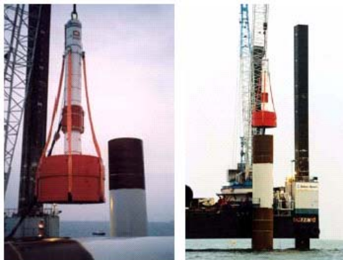
Figura 3.18: Fase di sollevamento del martello e successivo posizionamento in corrispondenza della testa del palo.
