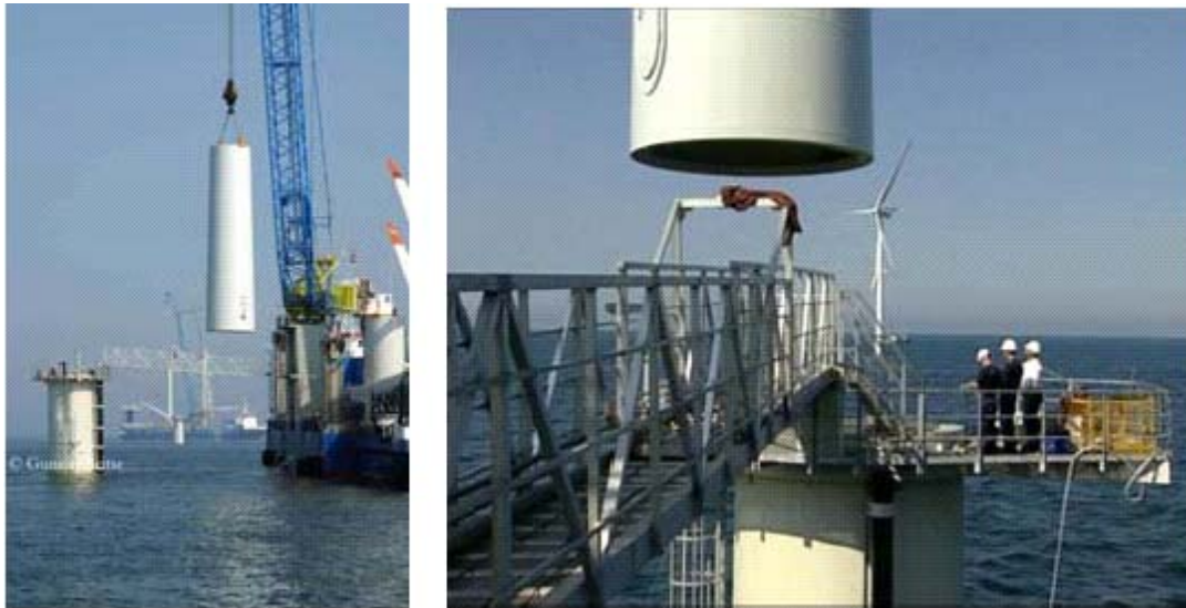
Figura 3.21: Installazione della torre in due componenti nel progetto di Horns Rev.
