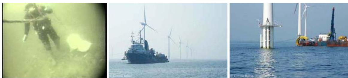
Figura 3.24: Installazione dei cavi di collegamento tra le turbine (in-field). Inserimento del cavo nel j-tube con l'assistenza di un sub.
