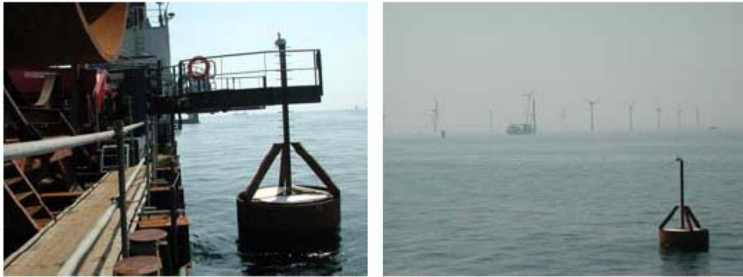
Figura 3.19: Faro di segnalazione temporaneo posizionato in corrispondenza del palo di fondazione.
