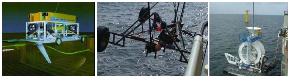
Figura 3.26: Mezzi utilizzati per l'interramento dei cavi.
