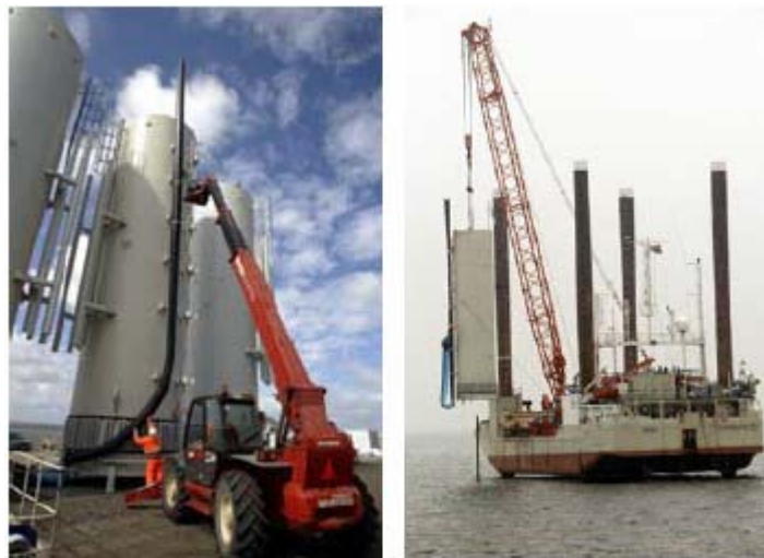
Figura 3.20: Installazione del pezzo di transizione a Horns Rev.
