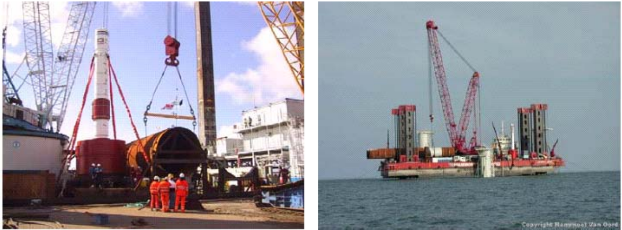
Figura 3.16: Caricamento dei pali di fondazione e fase di sollevamento del pontone nel punto di installazione dei pali di fondazione.
