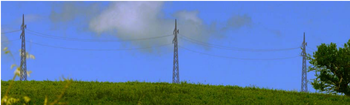
Figura 4.27: Fotoinserimento dei tralicci nell'immagine scattata dal punto P-9.
