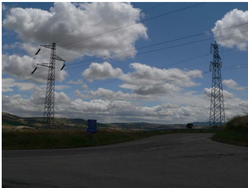
Figura 4.16: Tralicci della linea San Salvo-Termoli-Sinarca a pochi metri dall'incrocio tra la strada statale SS 157 e la provinciale SP 55, scattata dal punto P-13 in direzione SSW.
