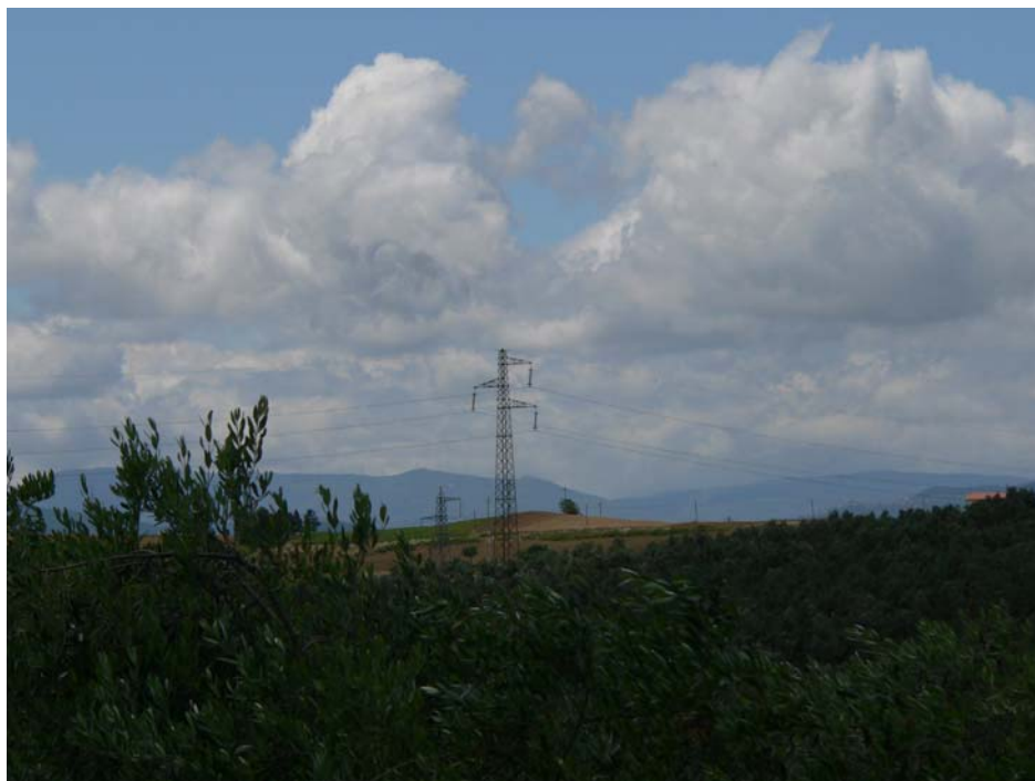
Figura 4.14: Tralicci delle linee del GRIN esistenti, dal punto P-11 in direzione SSW
