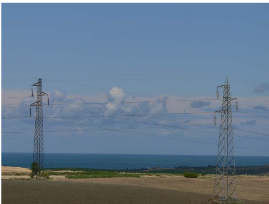
Figura 4.22: Linea RTN esistente fotografata dal punto P-20 in direzione NE.
