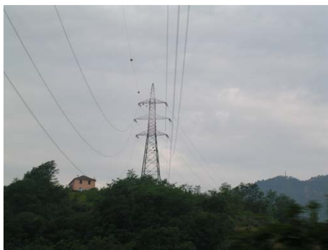
Figura 4.3: Esempio di applicazione di sfere colorate in una linea ad alta tensione: i cavi ad alta tensione sono già sufficientemente visibili perché hanno un diametro maggiore, su di essi non state fatte applicazioni di sfere. Sul cavo neutro, più sottile e quindi meno visibile, sono state applicate delle sfere per renderlo più visibile.
