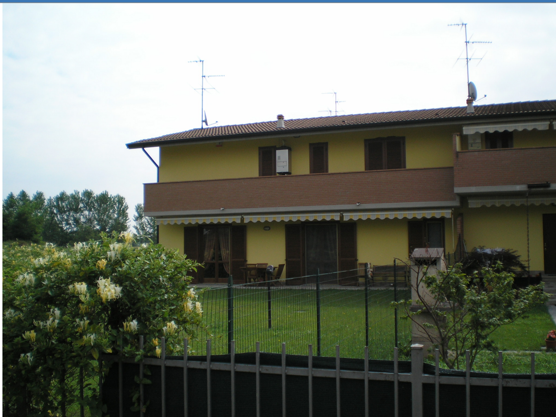
Foto 1 Foto della stazione di indagine
