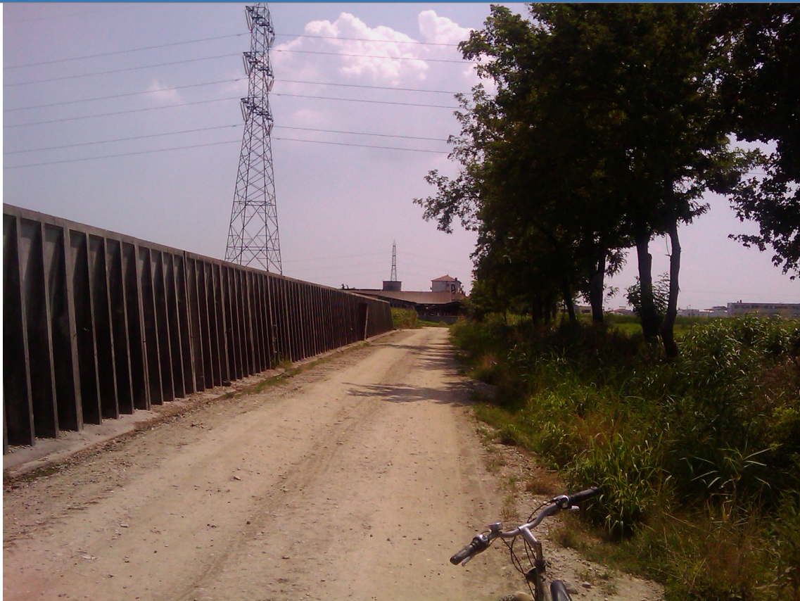
Foto 1 Foto della stazione di indagine
