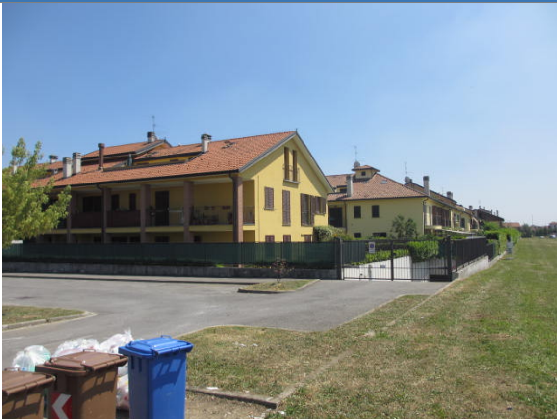
Foto 1 Foto della stazione di indagine
