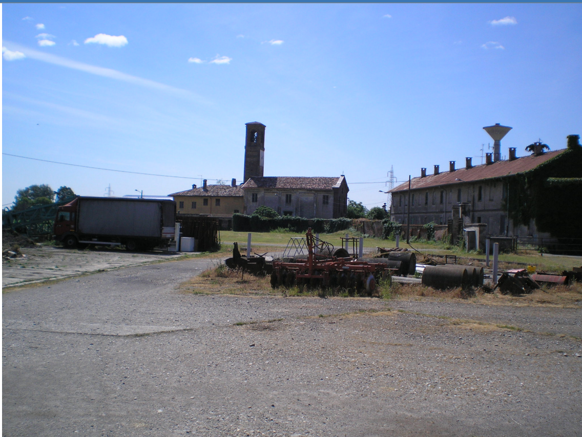
Foto 1 Foto della stazione di indagine
