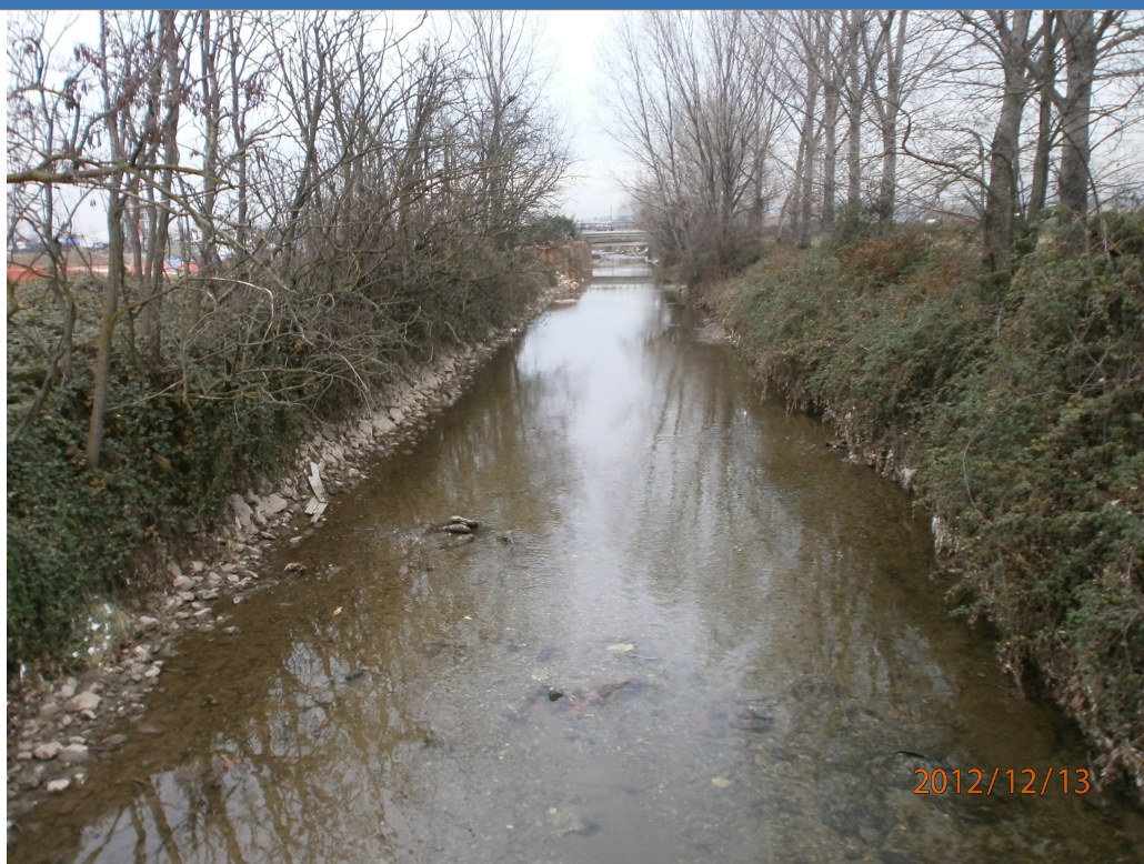
Foto 1 Foto attività di rilievo
