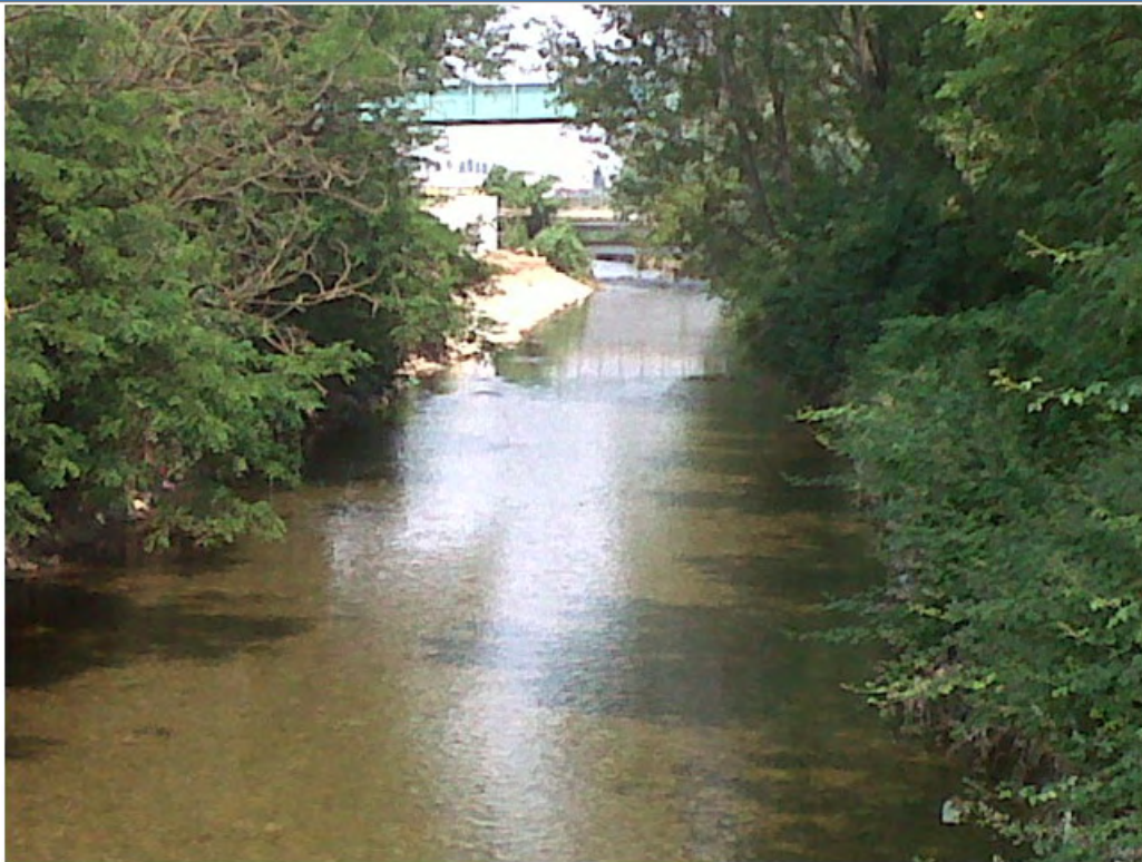
Foto 1 Foto attività di rilievo
