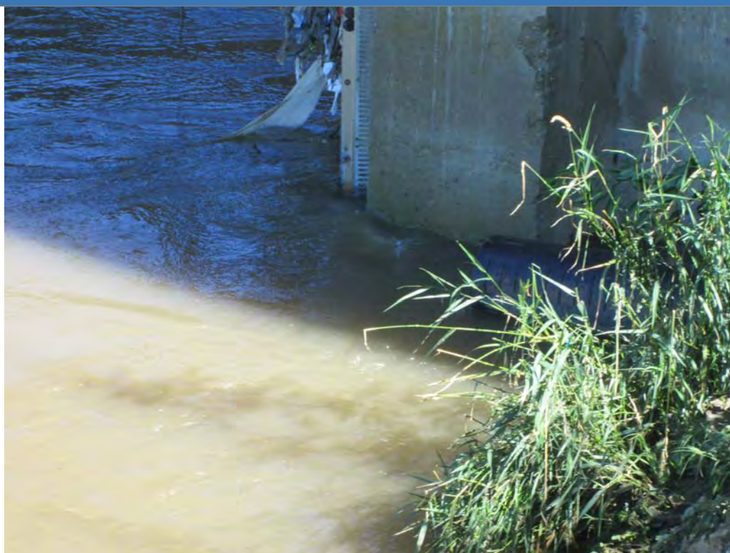
Foto 3 Foto attività di rilievo
