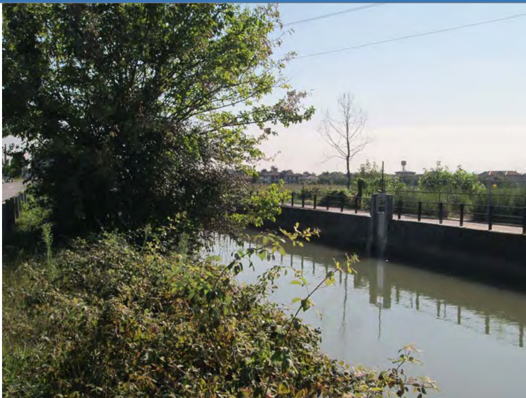
Foto 1 Foto attività di rilievo
