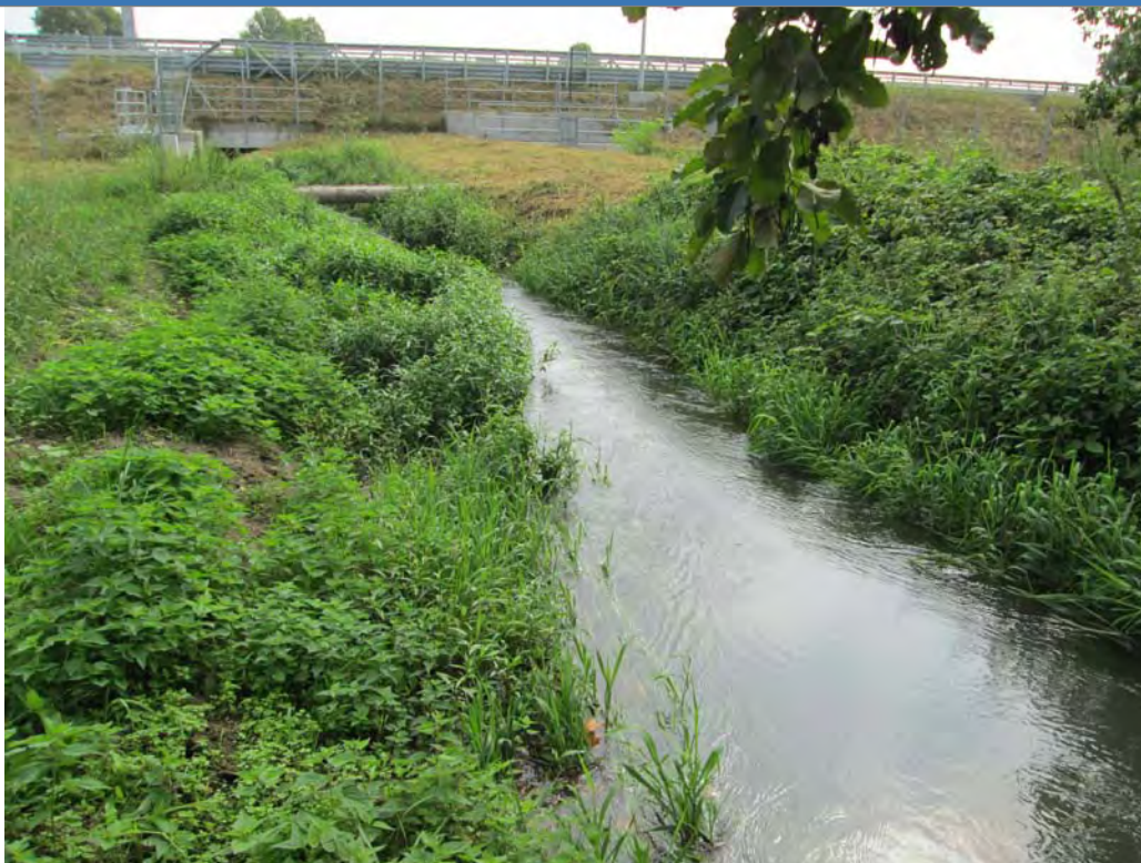
Foto 1 Foto attività di rilievo
