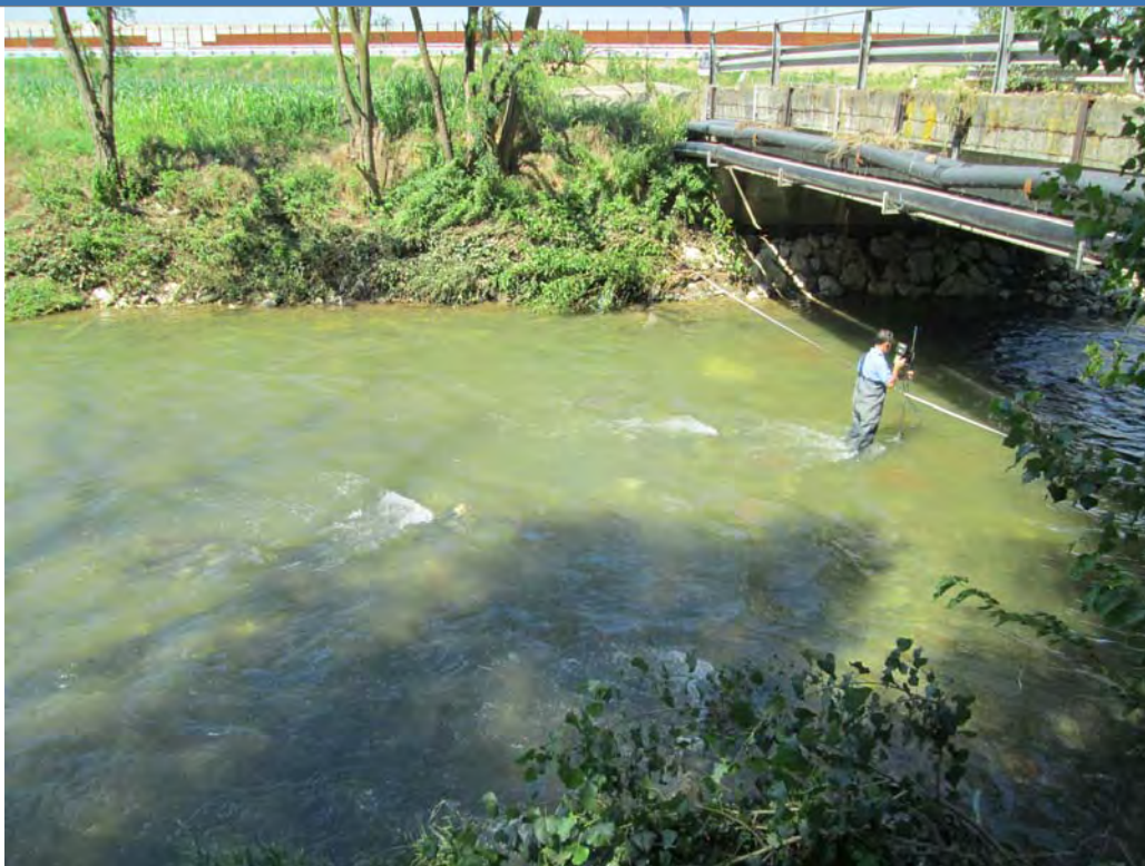
Foto 1 Foto attività di rilievo
