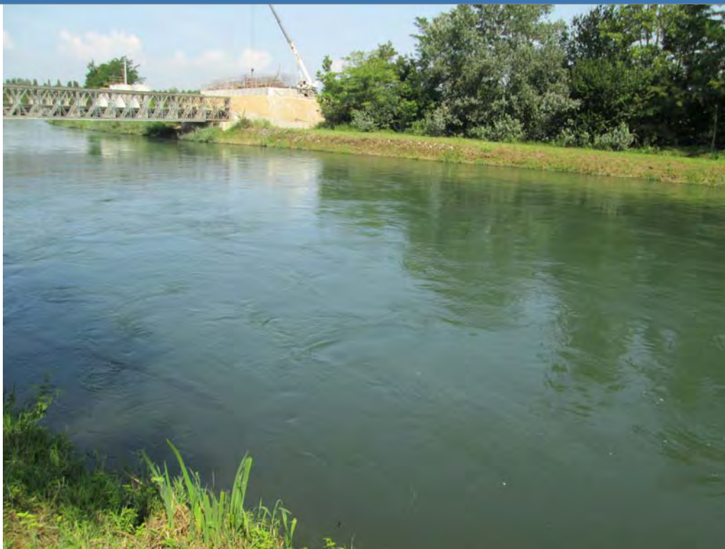
Foto 1 Foto attività di rilievo
