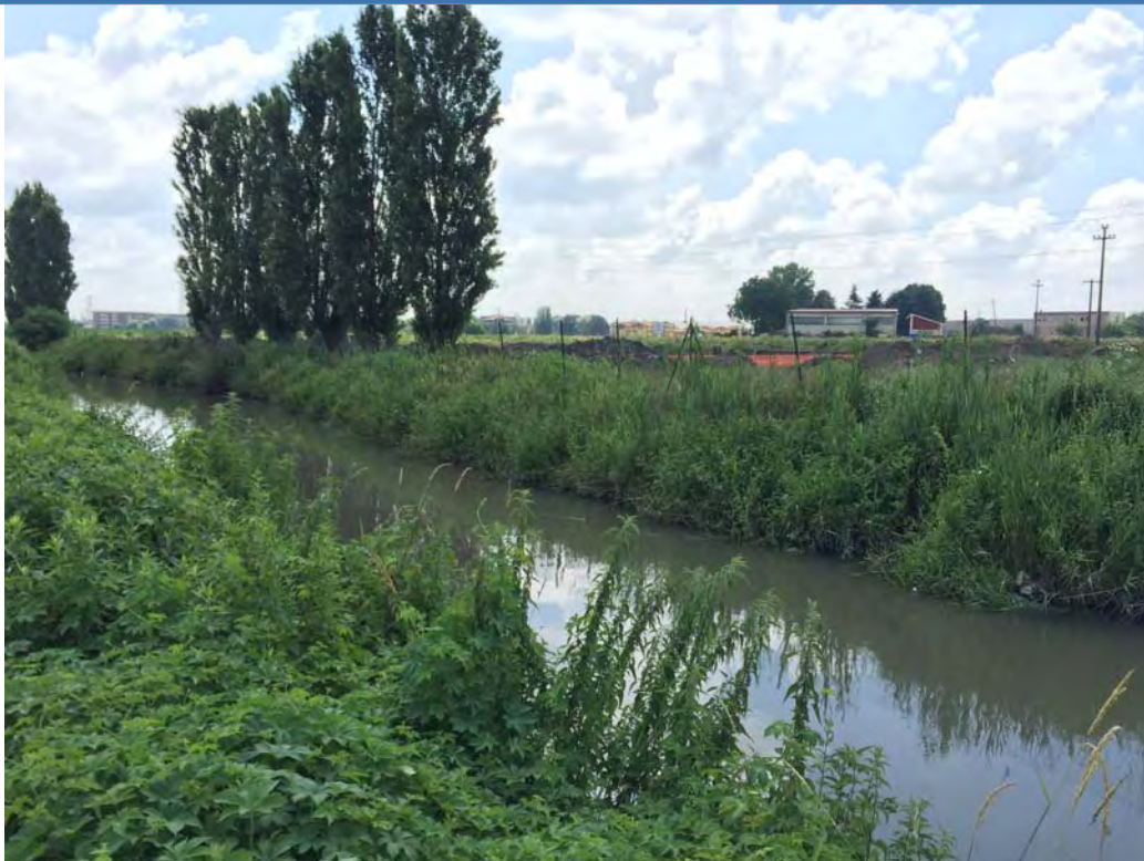
Foto 1 Foto attività di rilievo
