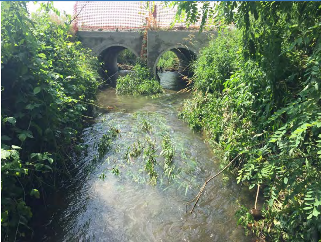
Foto 1 Foto attività di rilievo
