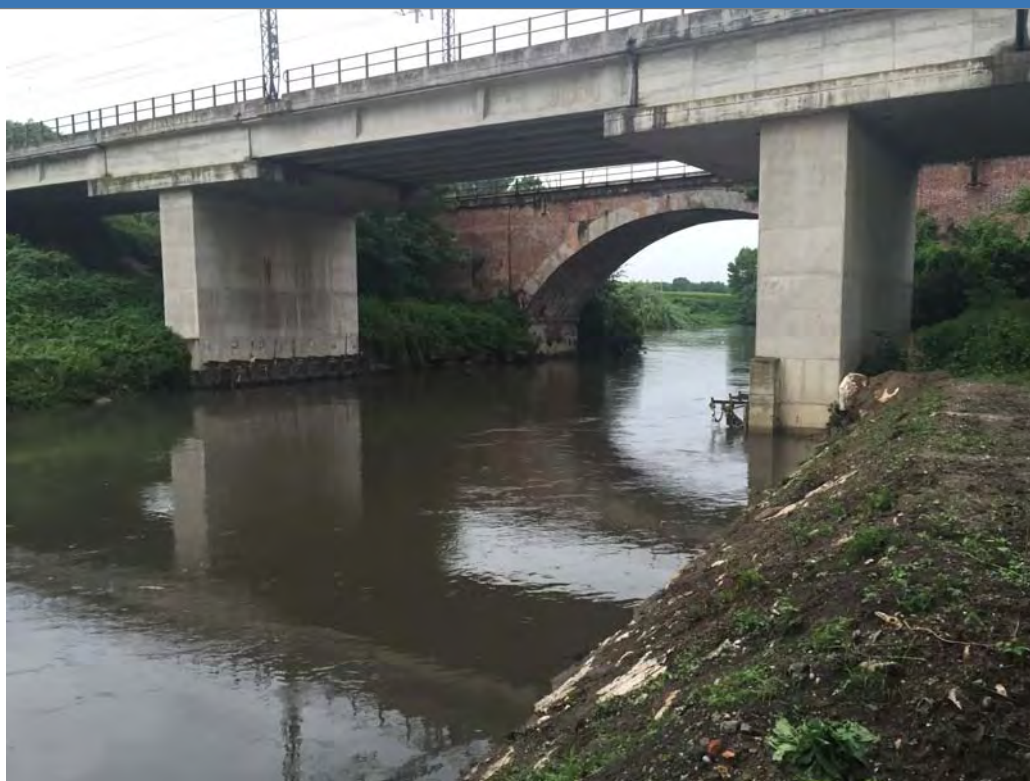
Foto 1 Foto attività di rilievo
