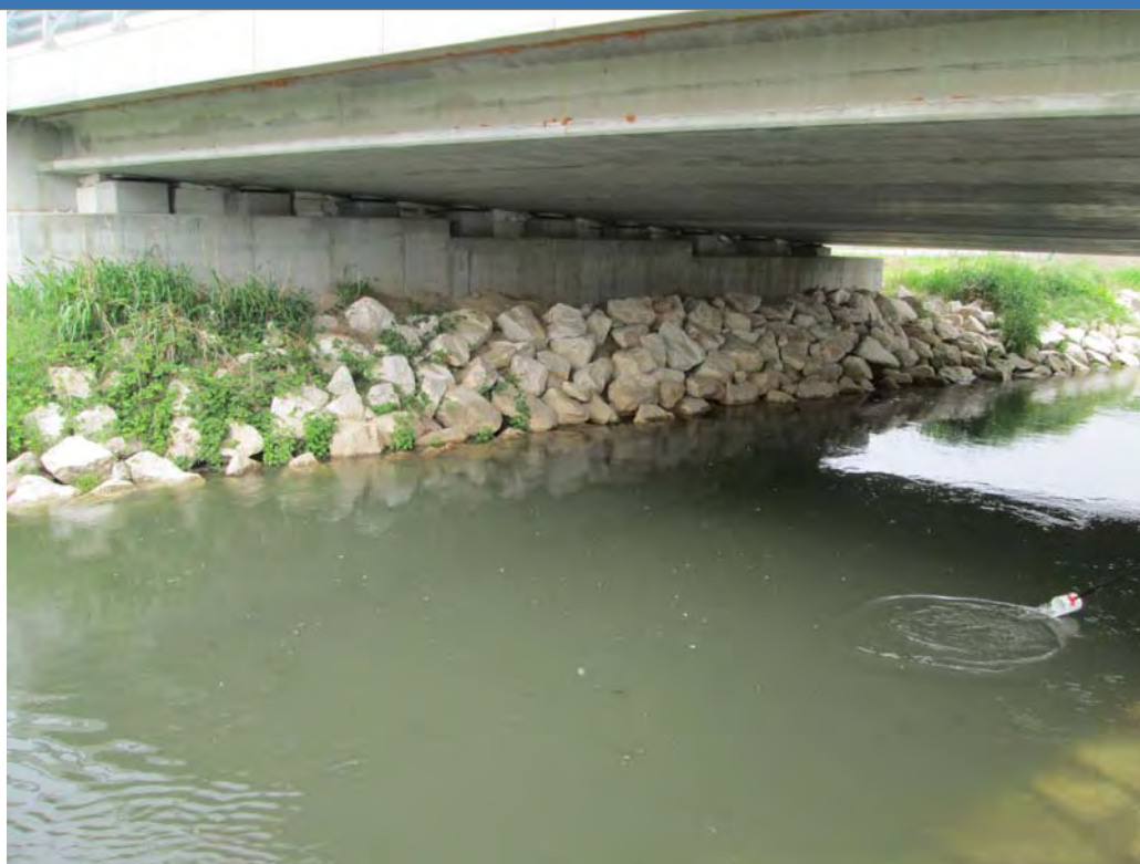
Foto 1 Foto attività di rilievo
