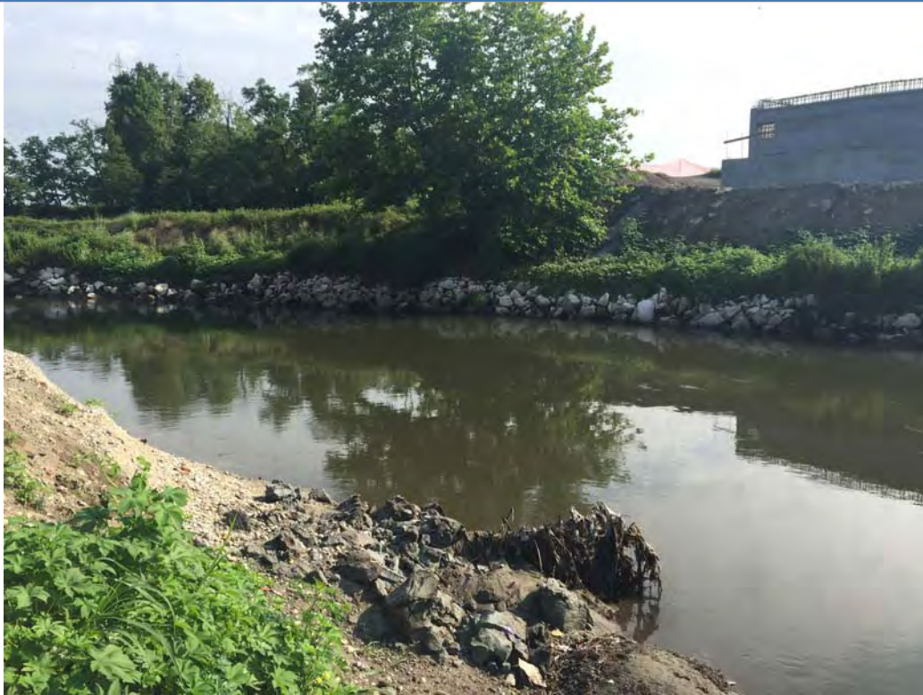
Foto 1 Foto attività di rilievo
