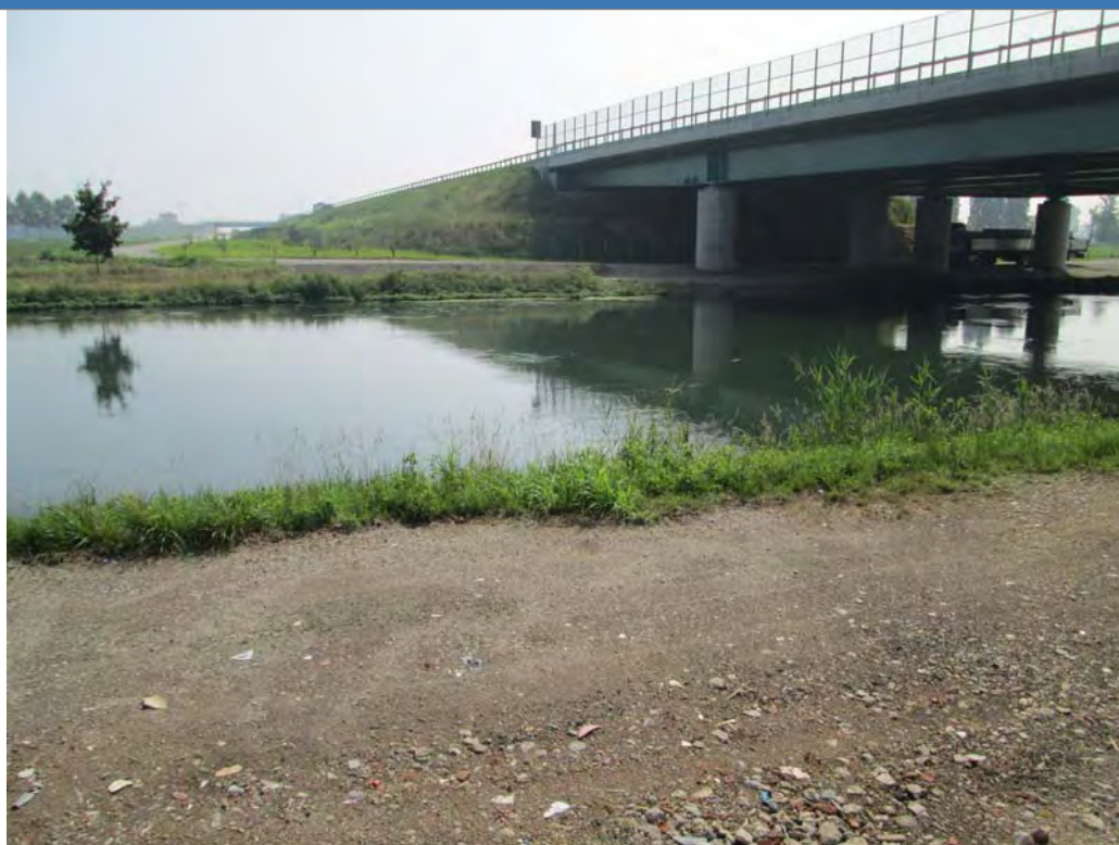
Foto 1 Foto attività di rilievo
