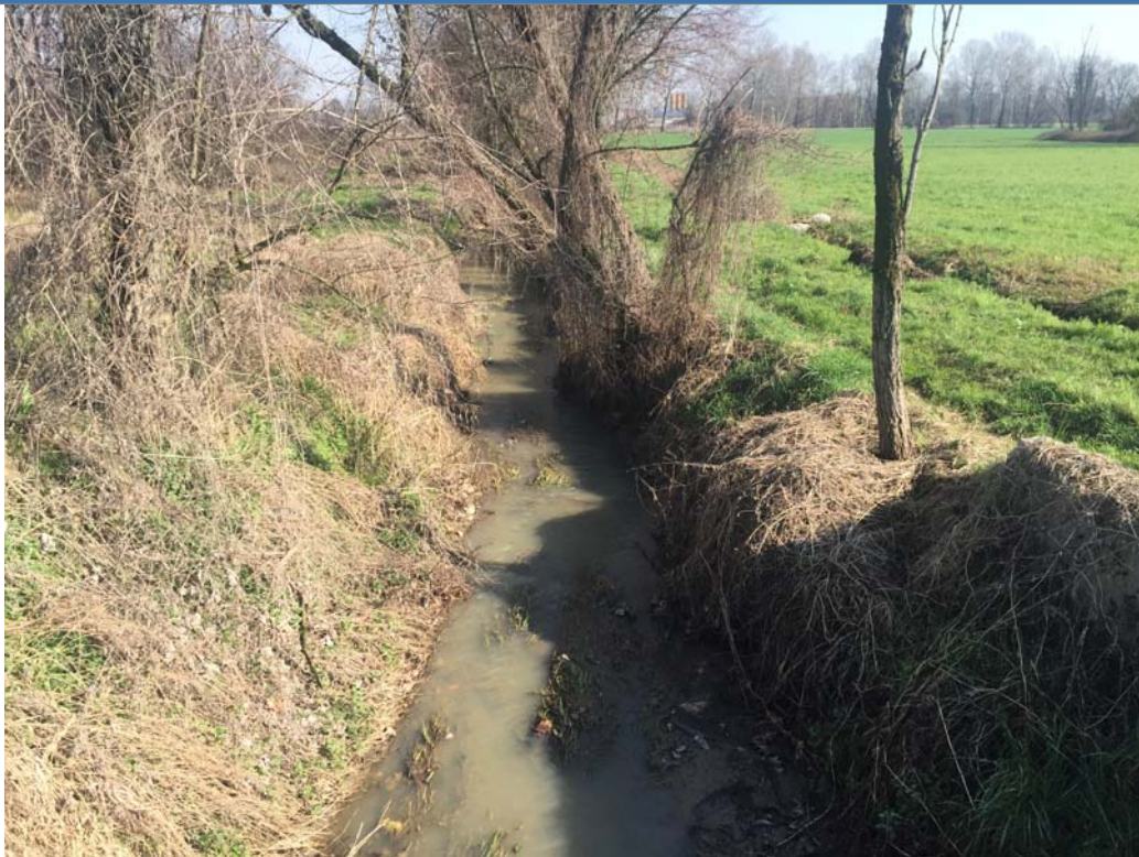
Foto 1 Foto attività di rilievo
