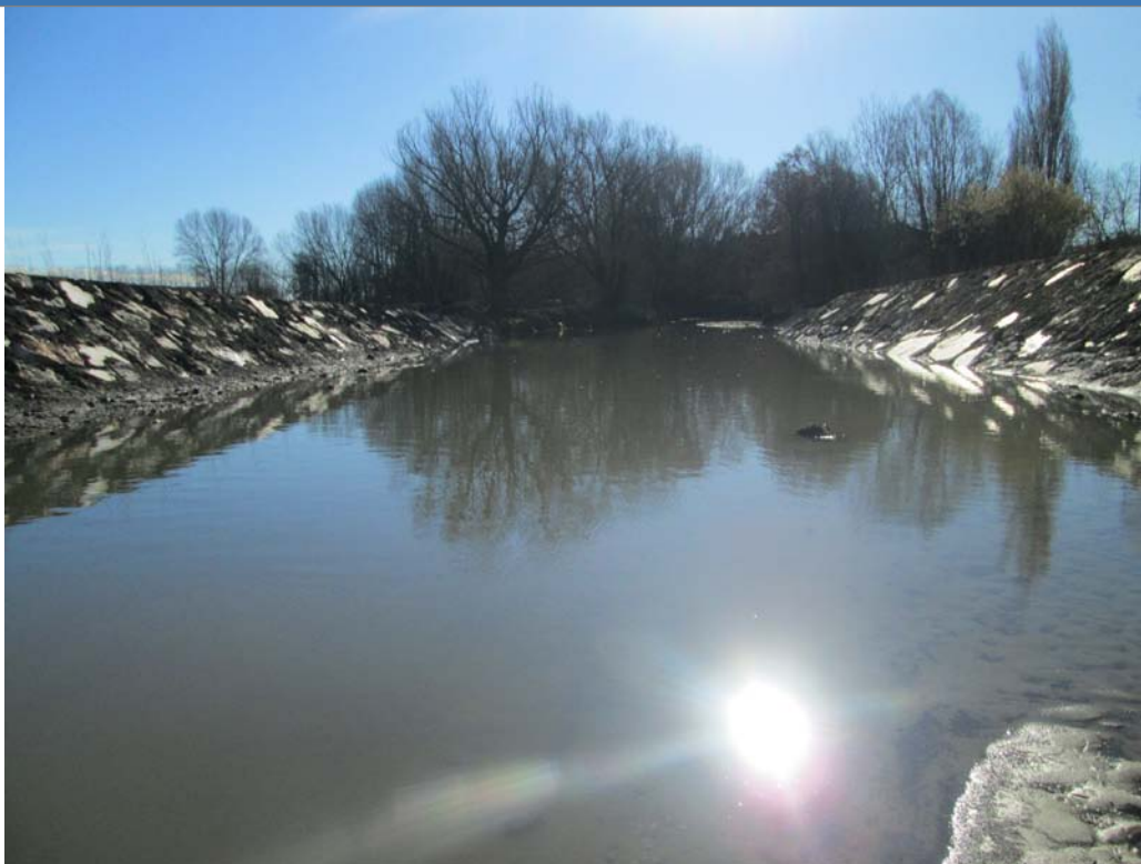
Foto 1 Foto attività di rilievo
