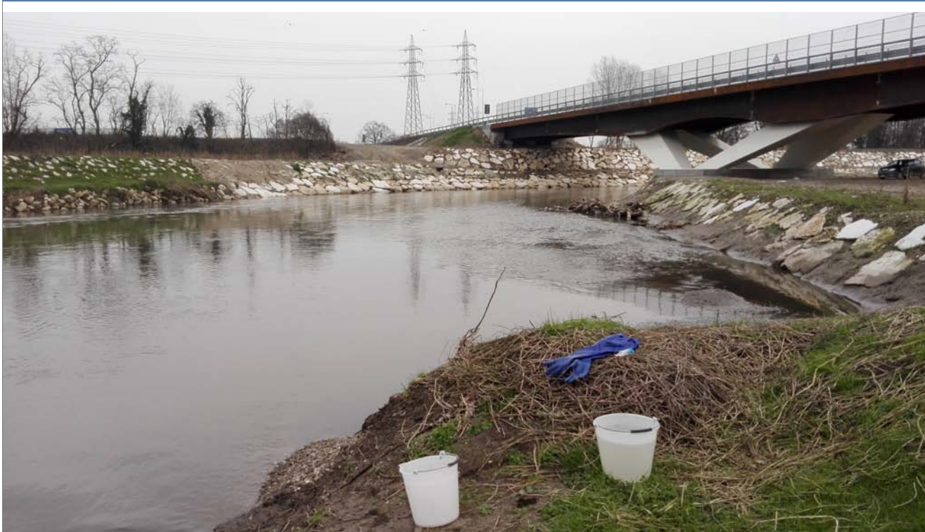
Foto 1 Foto attività di rilievo
