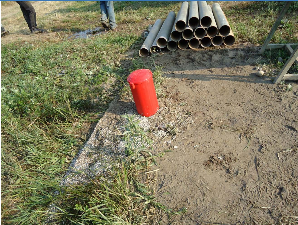
Foto 1 Foto della stazione di indagine
