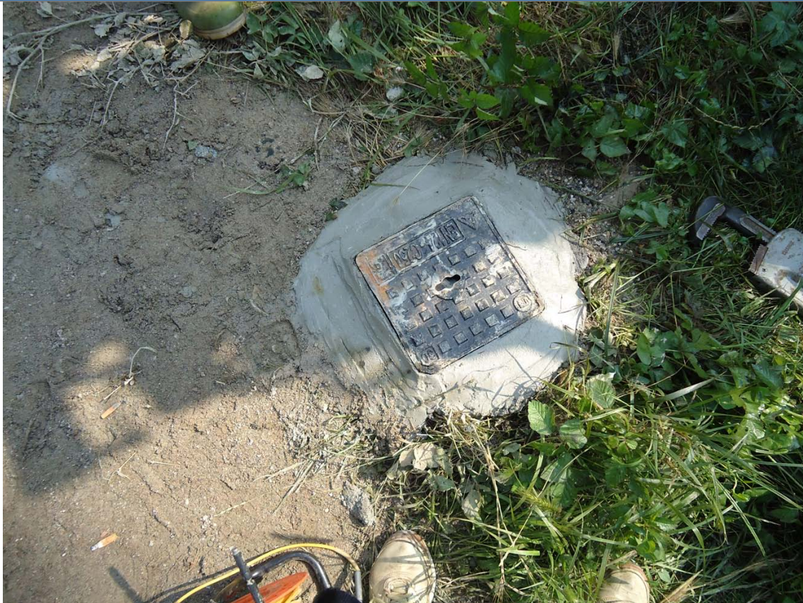
Foto 1 Foto della stazione di indagine
