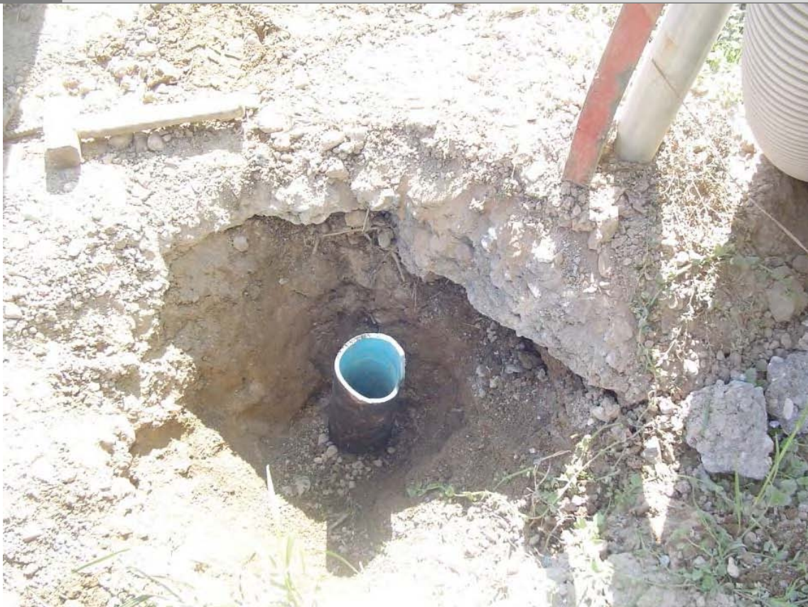
Foto 2 Foto della stazione di indagine
