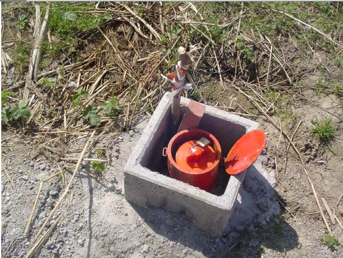
Foto 2 Foto della stazione di indagine
