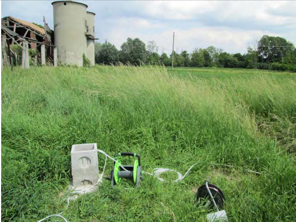
Foto 1 Foto attività di rilievo
