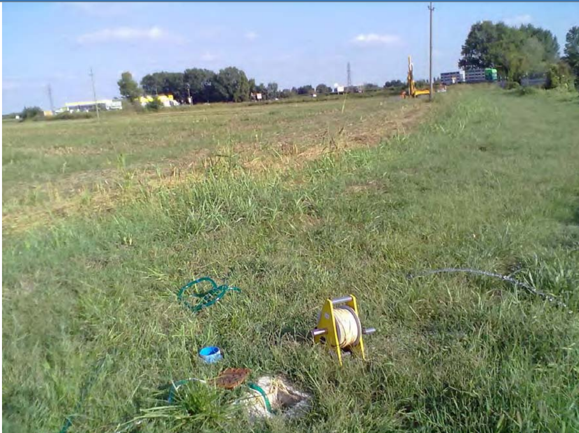
Foto 1 Foto della stazione di indagine
