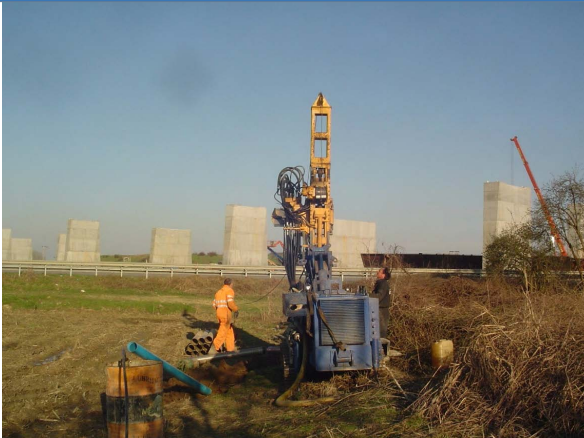
Foto 1 Foto della stazione di indagine
