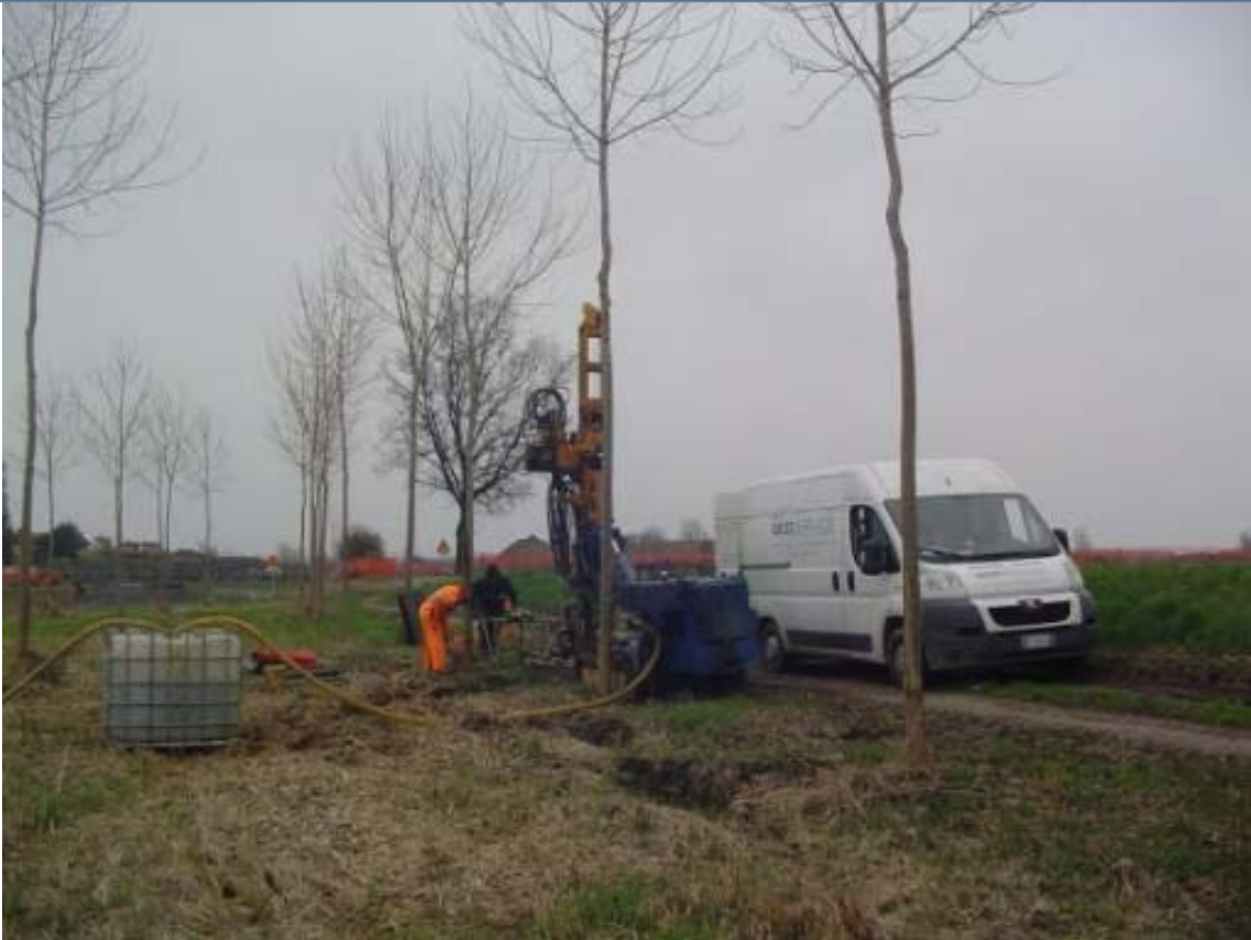
Foto 1 Foto della stazione di indagine
