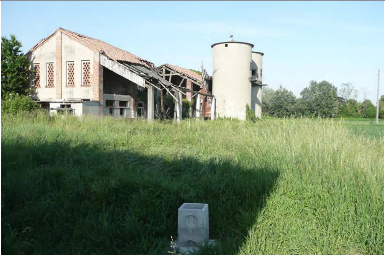
Foto 2 Foto della stazione di indagine
