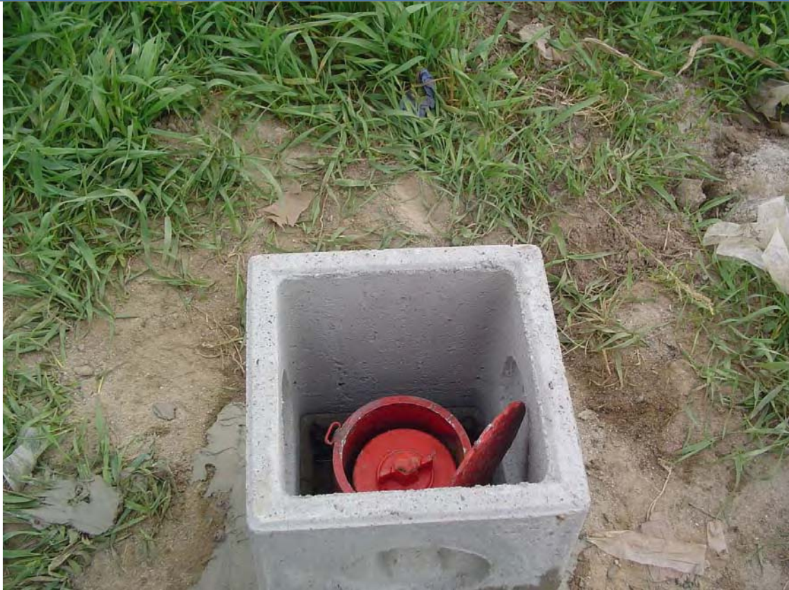
Foto 1 Foto della stazione di indagine
