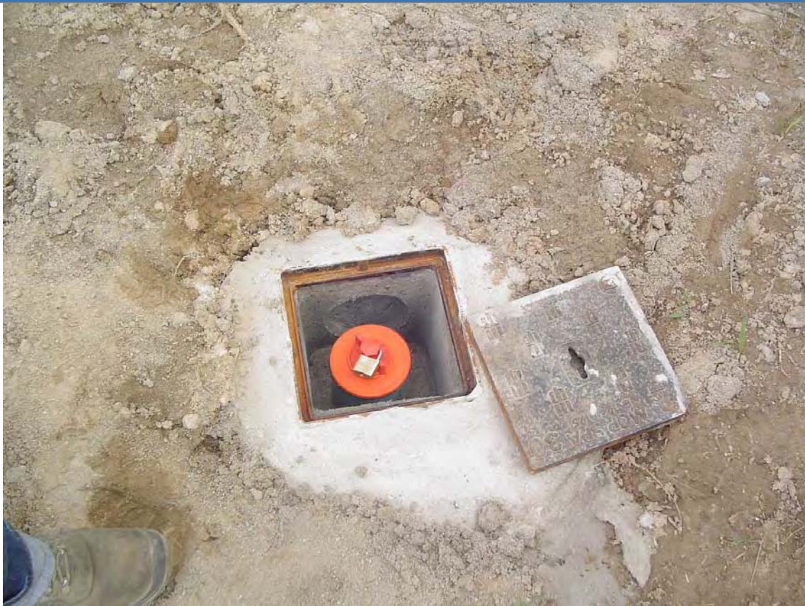
Foto 1 Foto della stazione di indagine
