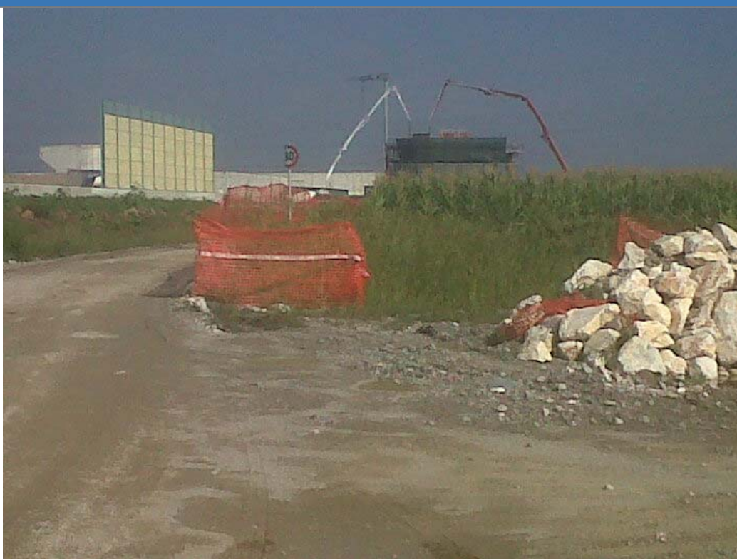
Foto 1 Foto attività di rilievo
