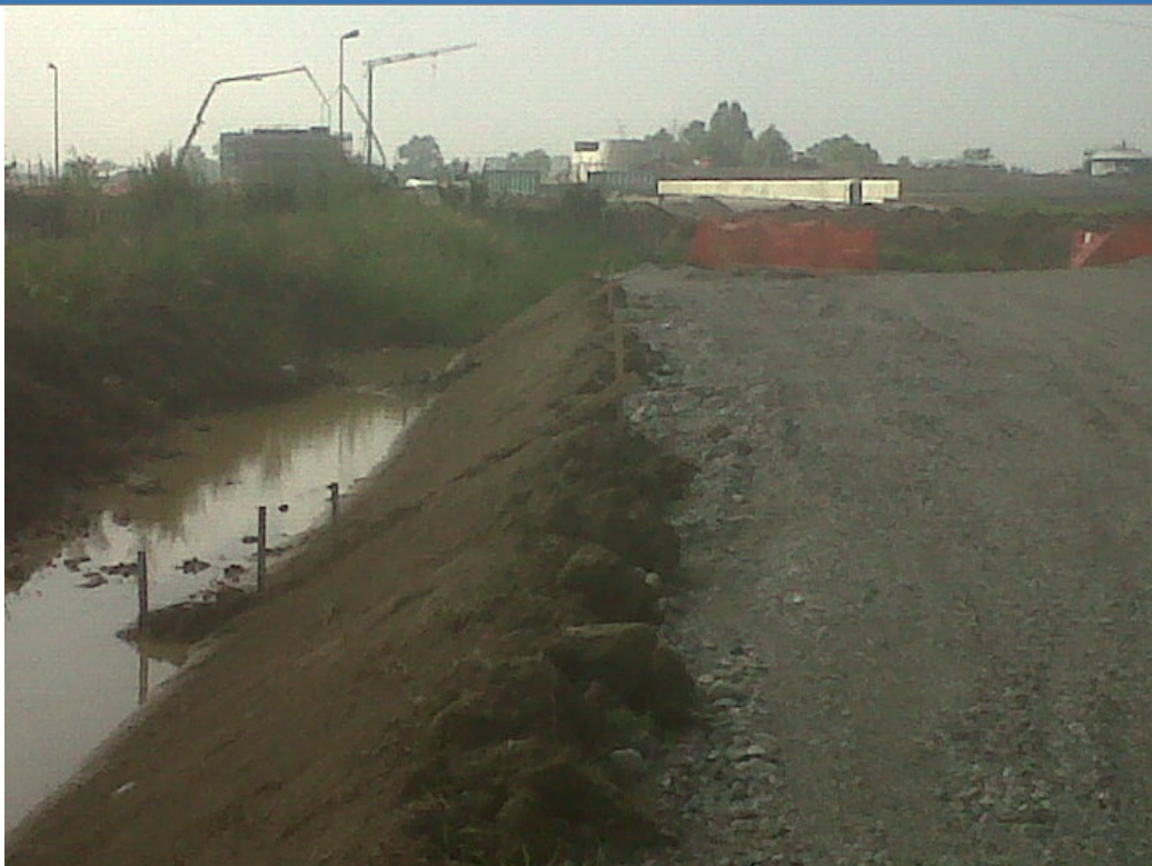
Foto 1 Foto attività di rilievo
