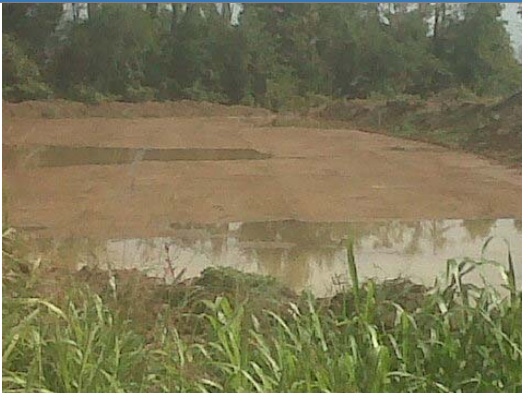
Foto 1 Foto attività di rilievo
