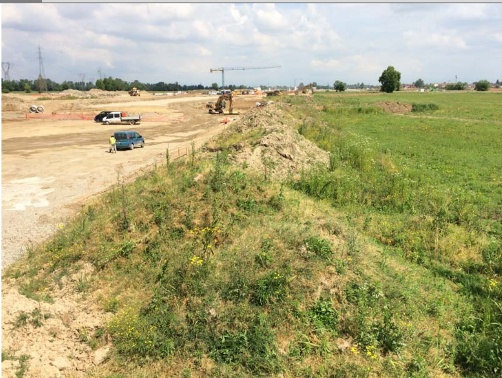
Foto 2 Foto attività di rilievo
