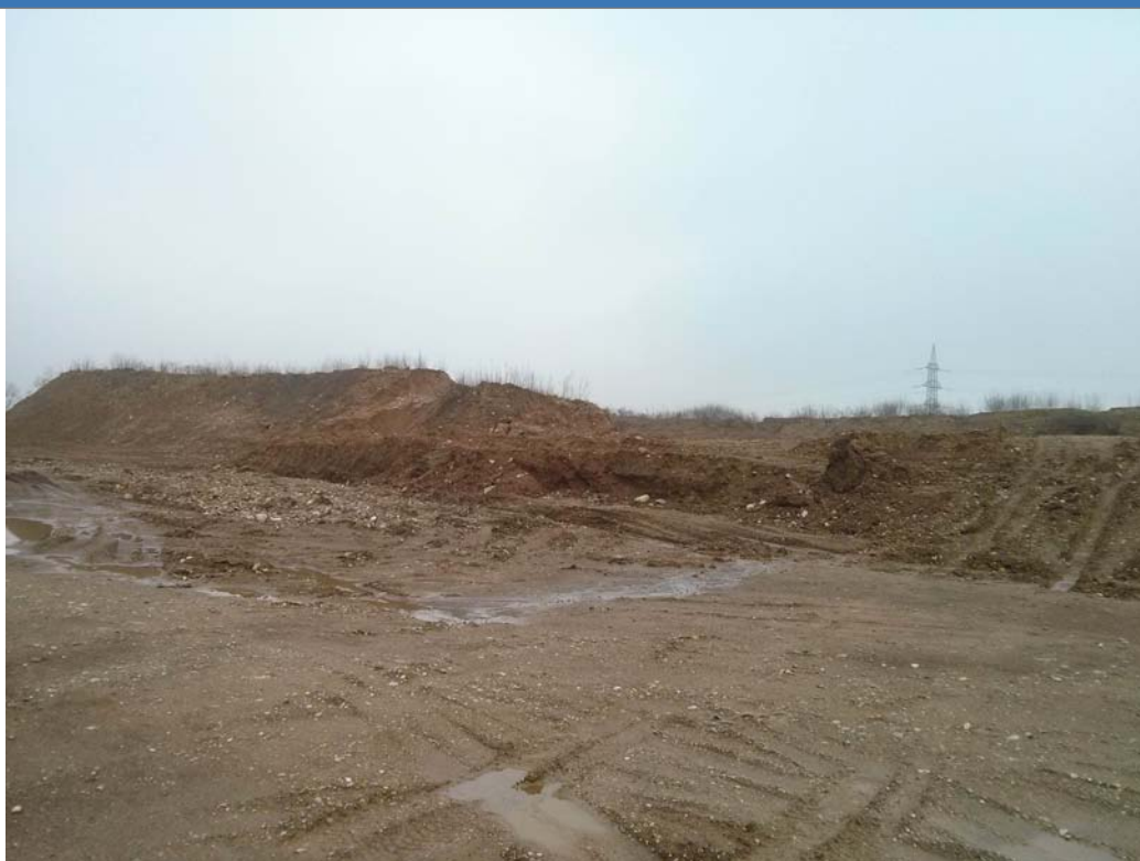
Foto 1 Foto attività di rilievo
