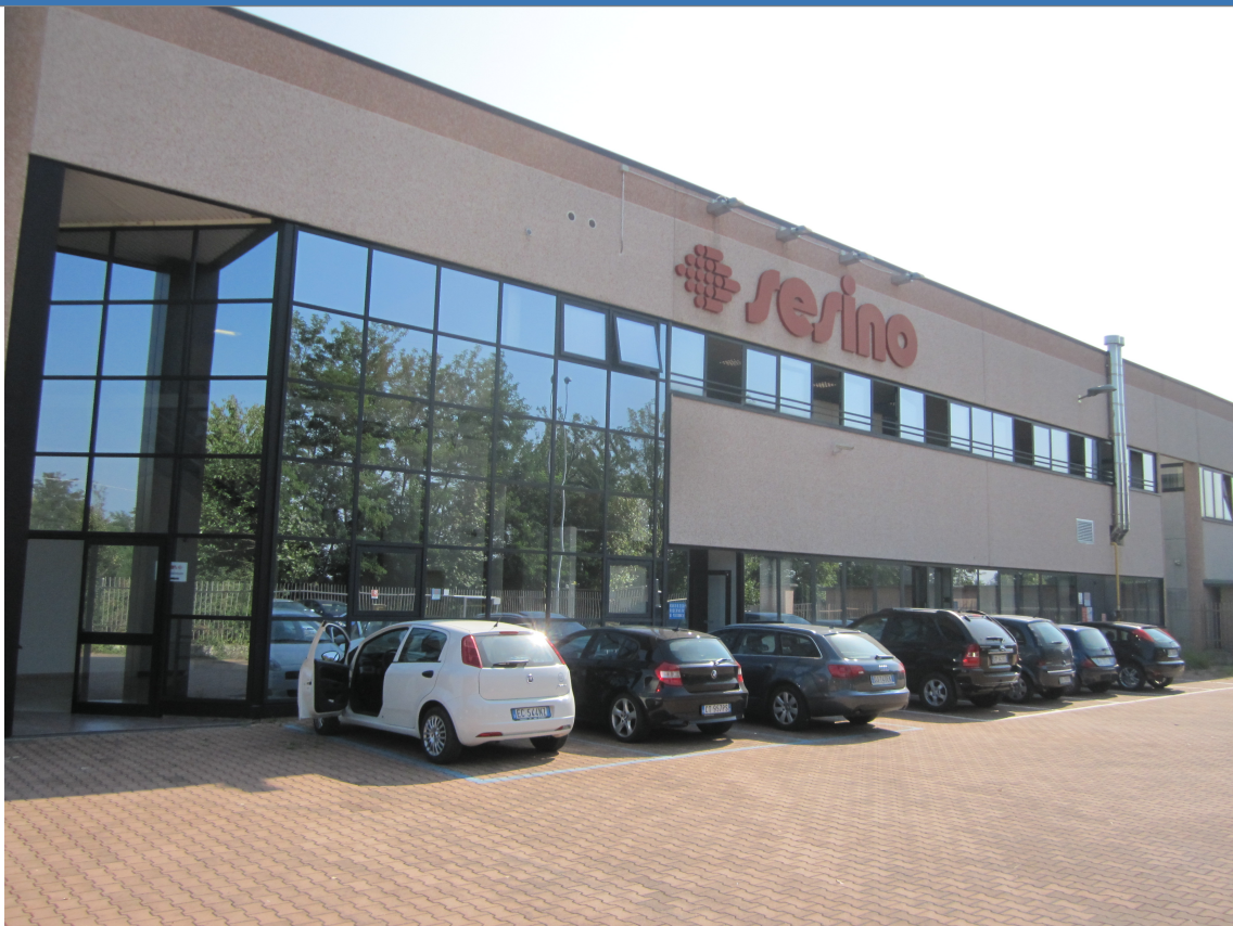
Foto 1 Foto della stazione di indagine
