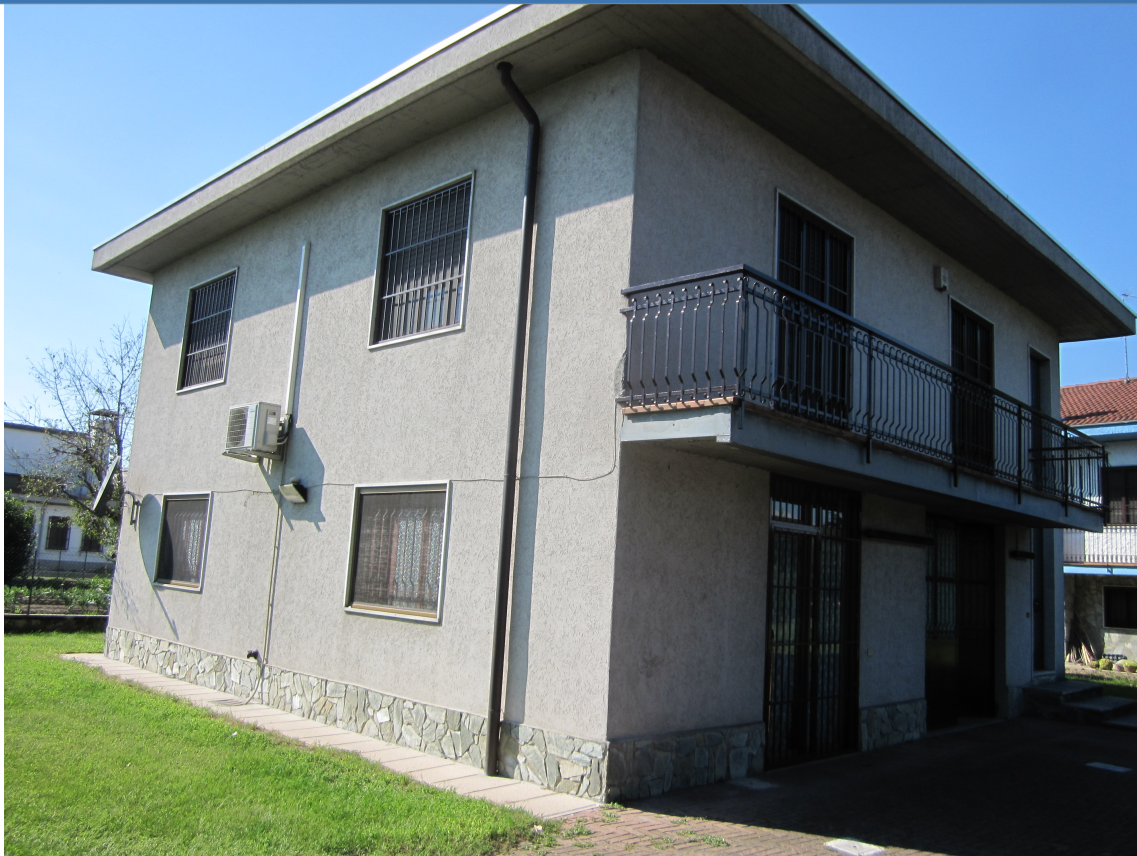
Foto 1 Foto della stazione di indagine
