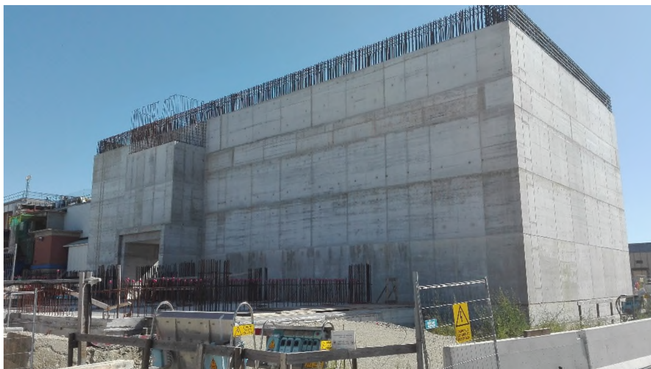
Figura 2-3 - Edificio di deposito (prospetto Nord)
