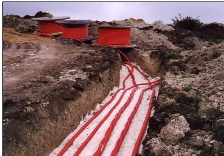
Particolare posa cavi elettrici.
