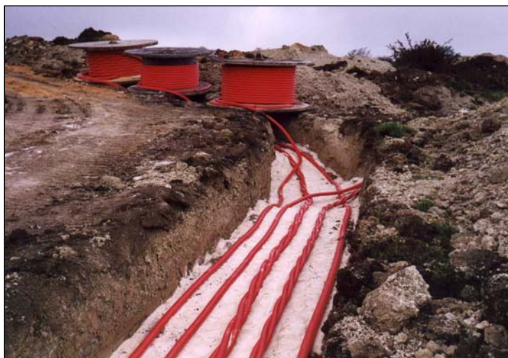
Particolare posa cavi elettrici.
