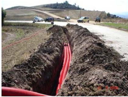
Fig. 1.4 - Foto illustrativa della messa in posa dei cavidotti MT
