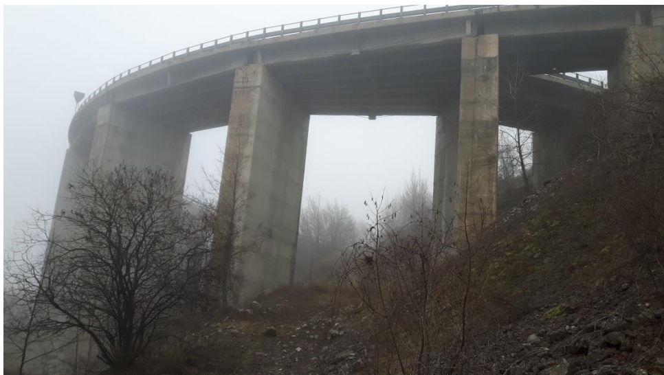
Figura 4: viadotto rampa di svincolo di Tornimparte
