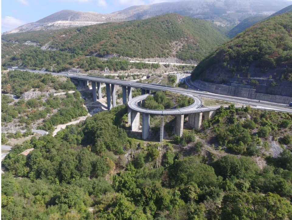
Figura 3: viadotto S. Onofrio e svincolo di Tornimparte
