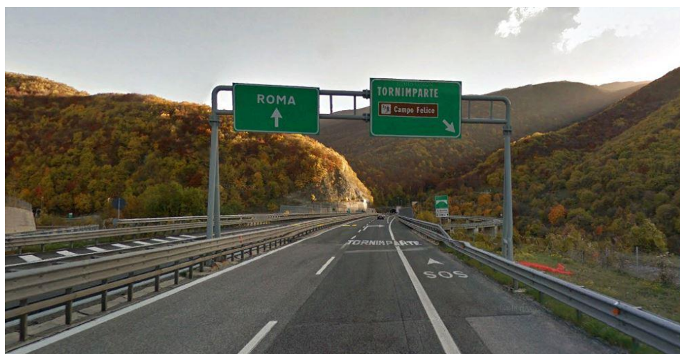
Figura 2: A24 al km 85 circa, viadotto S. Onofrio e svincolo di Tornimparte – vista verso galleria S.Rocco
