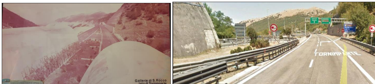
Figura 1: foto d'archivio dell'autostrada prima della costruzione dello svincolo a confronto con la situazione attuale- vista da galleria S.Rocco
