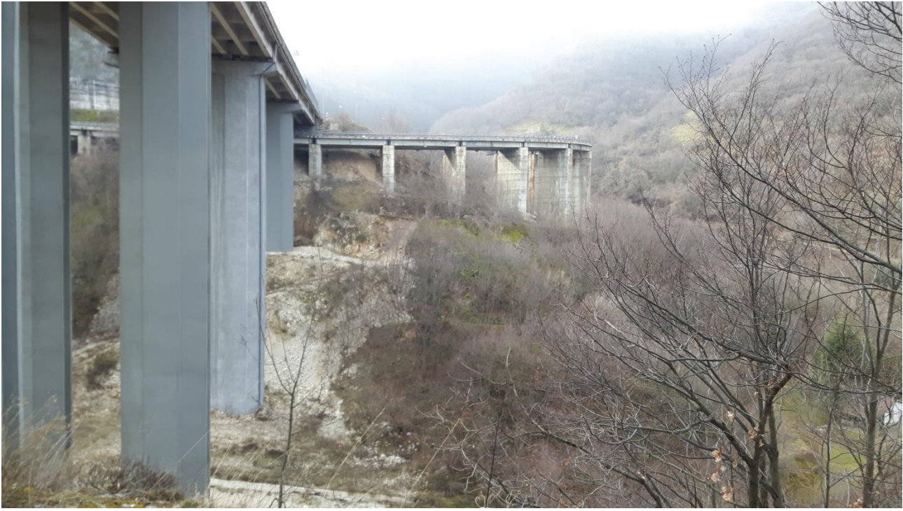
Figura 3: viadotto S. Onofrio e svincolo di Tornimparte
