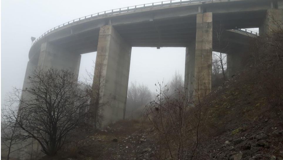
Figura 4: viadotto rampa di svincolo di Tornimparte
