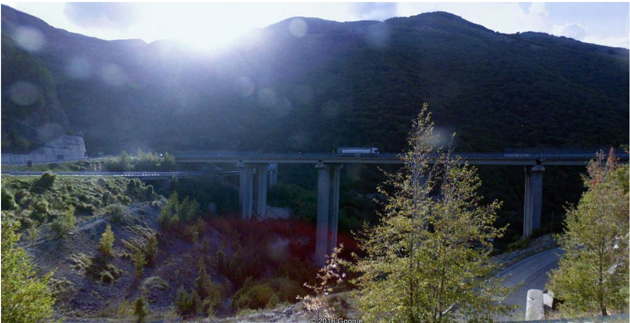
Figura 1: Vista Viadotto S. Onofrio e della rampa di svincolo di Tornimparte
