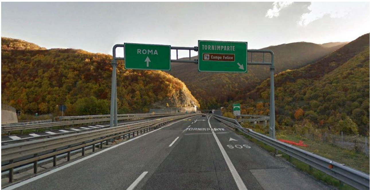
Figura 2: A24 al km 85 circa, viadotto S. Onofrio e svincolo di Tornimparte
