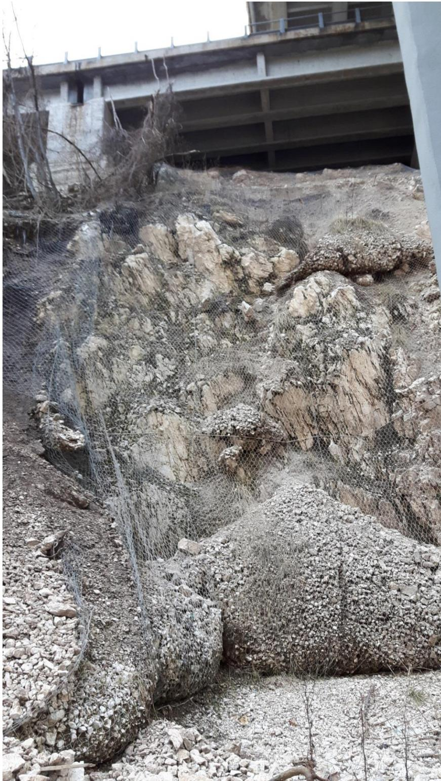
Figura 41. Stazione Geomeccanica 4: particolare degli accumuli detritici nella rete paramassi.
