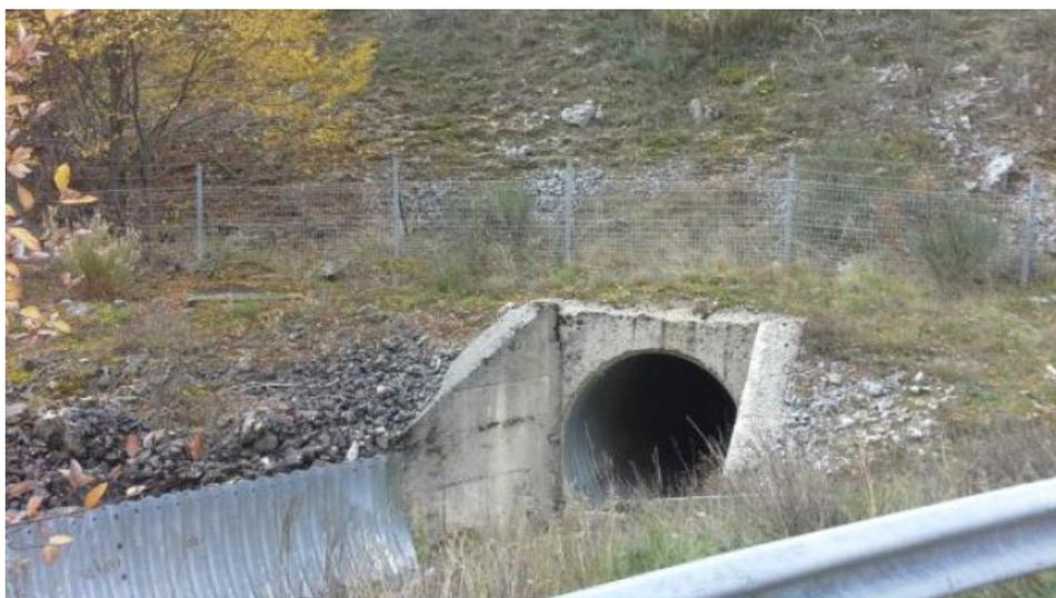
Figura 9: Foto del canale tipo ARMCO recapito dell'impianto di trattamento e della condotta di attraversamento sotto la rampa autostradale di direzione L'Aquila.
